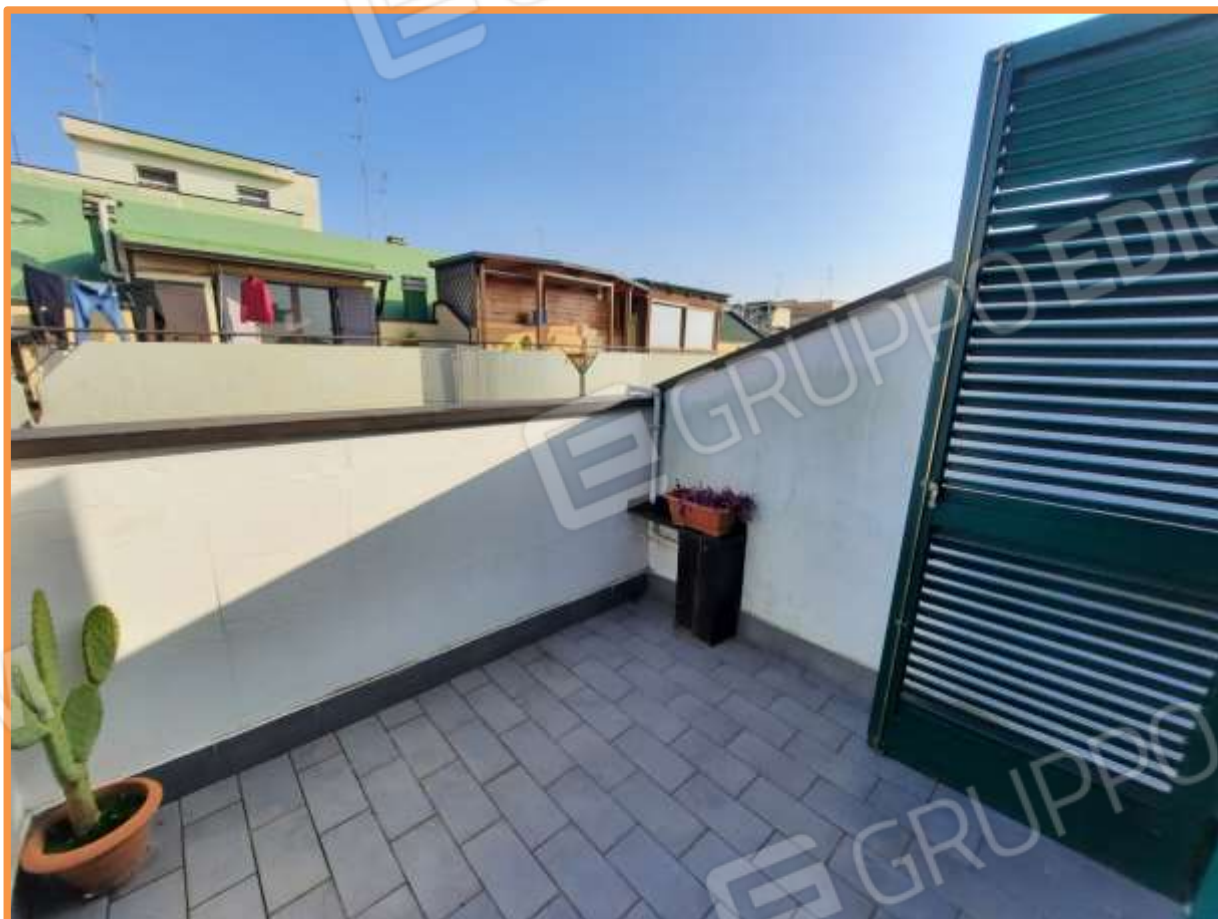
FOTO N° 19. Terrazza a livello con accesso dall'open space. Vista verso la direzione nord-est.
