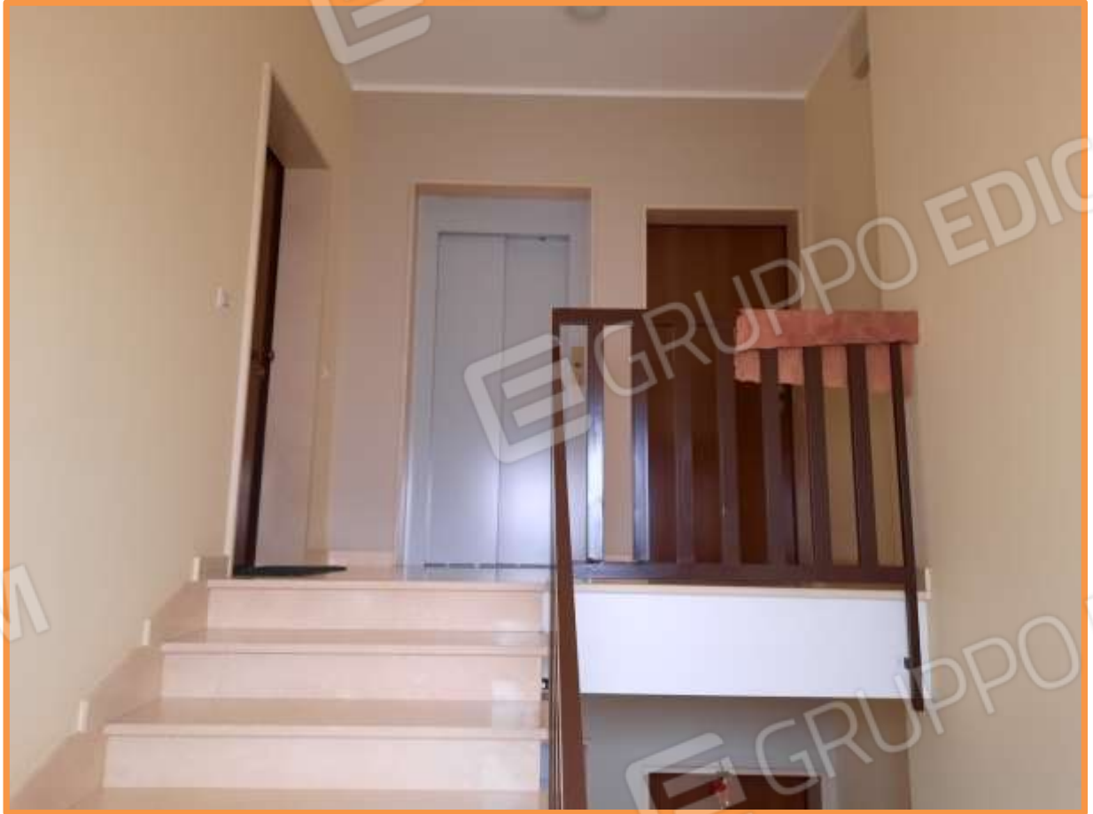
FOTO n° 3. Vano scala. Terzo piano. Accesso al sottotetto destinato a deposito.
