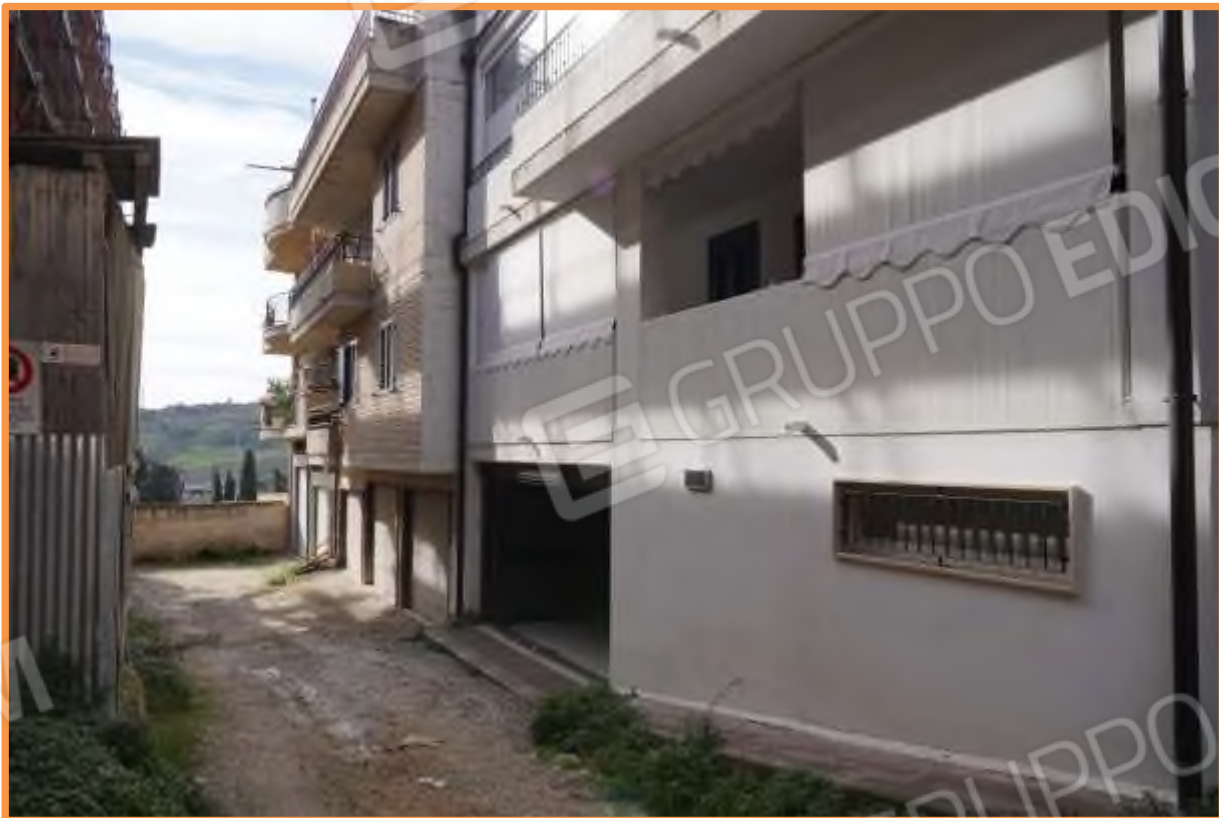
FOTO n° 2. Prospetto dell'edificio di sud est sulla nuova strada di p.r.g.. Particolare della rampa e dell'apertura di accesso carrabile al piano seminterrato.
