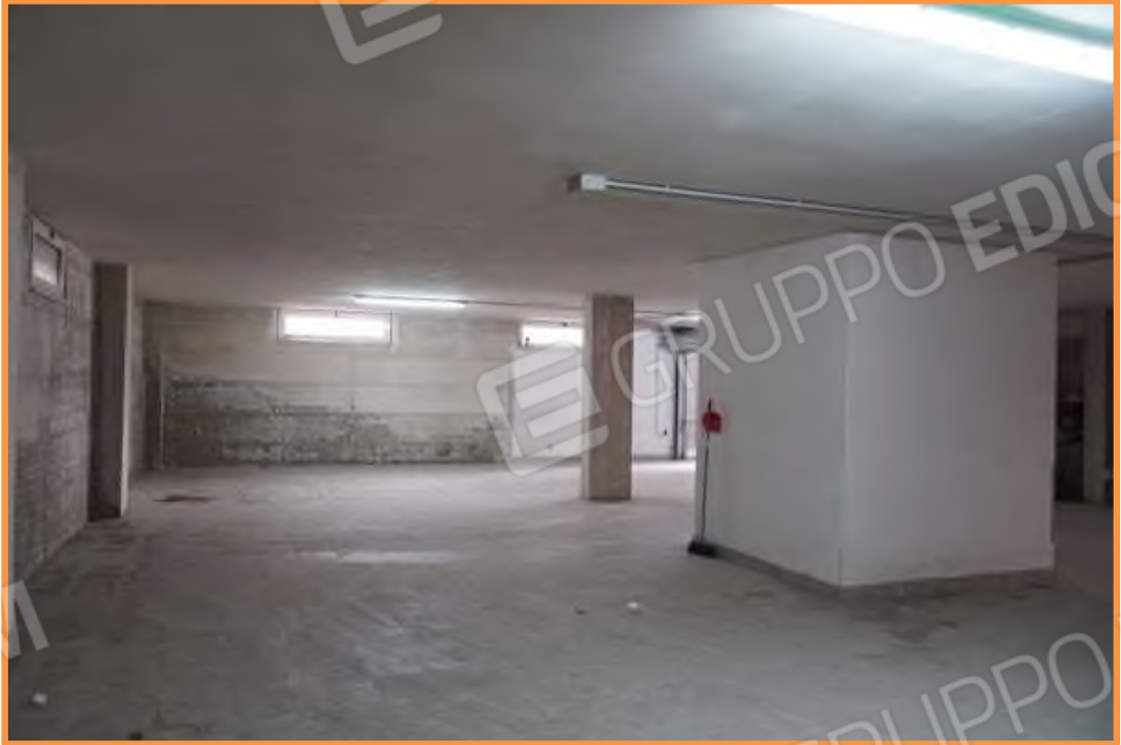
FOTO N° 9. Come foto n° 8. Vista verso la direzione opposta, verso sud-est. Sul fondo a destra si intravede l'entrata carrabile.
