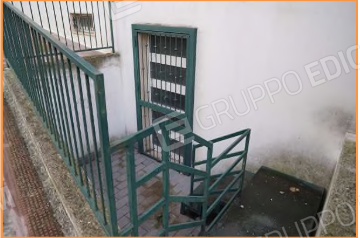
FOTO n° 4. Come foto n° 3, particolari.
