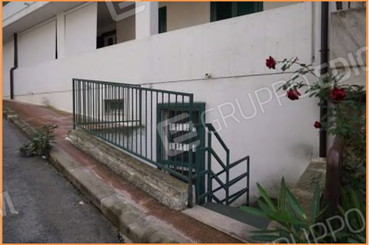
FOTO n° 3. Prospetto dell'edificio di sud ovest sulla via [REDACTED] Particolare dell'apertura di accesso pedonale al piano seminterrato.
