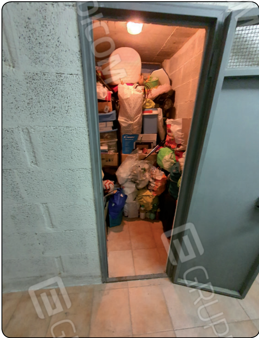
Foto 14: CANTINOLA pertinenziale al piano interrato
