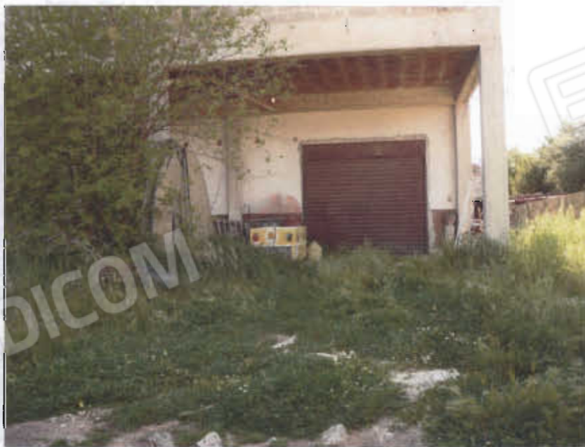
Foto 4 Locale deposito C/2 visto dalla strada
