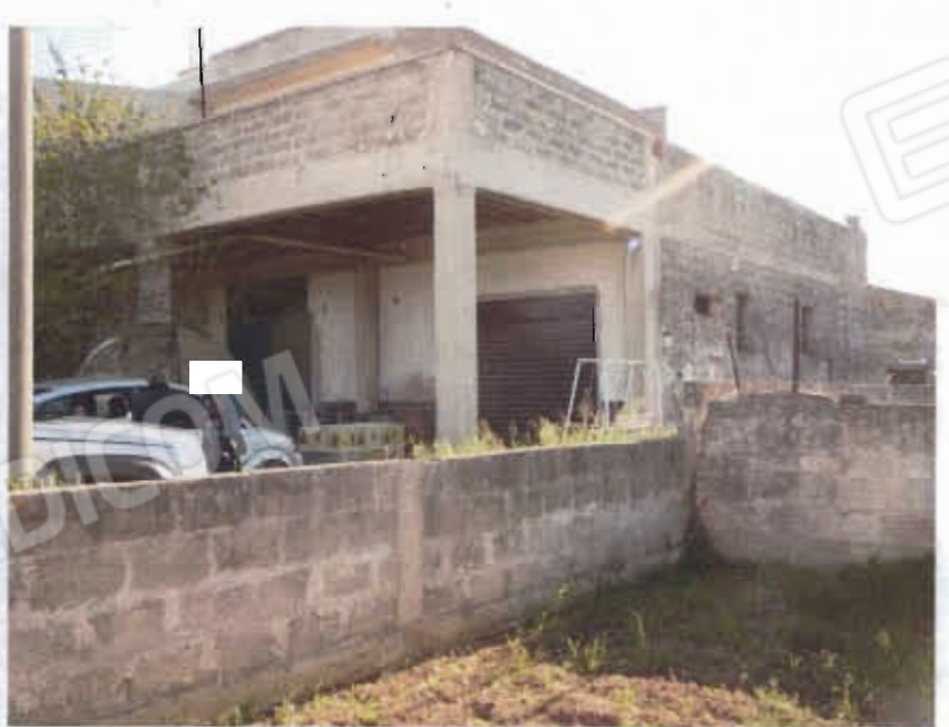
Foto 2 Locale deposito C/2 visto dalla strada
