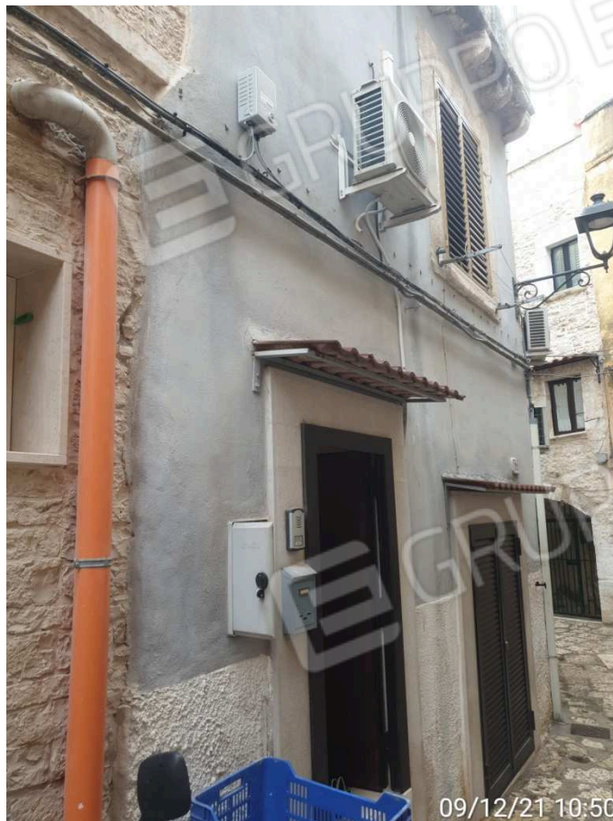
Foto 1- PROSPETTO VIA PENDILE
