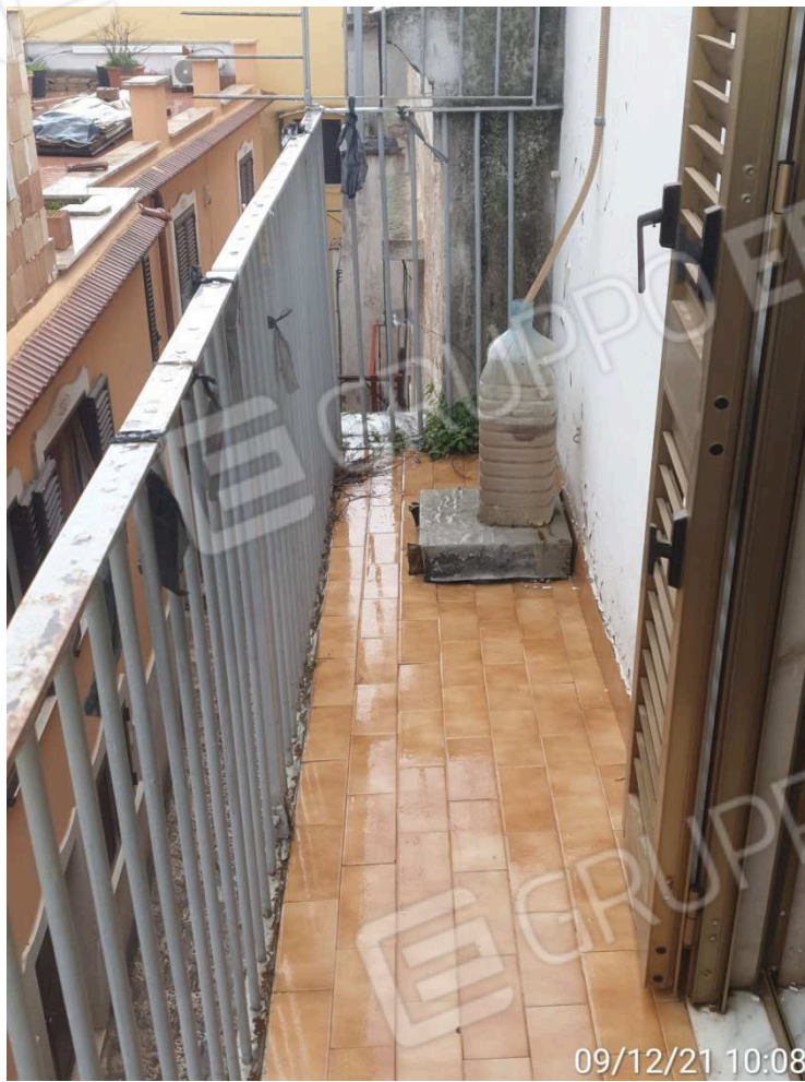
FOTO N.17 - BALCONE SECONDO PIANO
