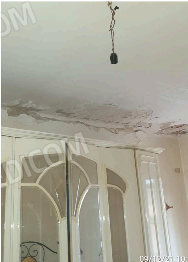
FOTO 15,16: FENOMENO INFILTRATIVO AL SECONDO PIANO
