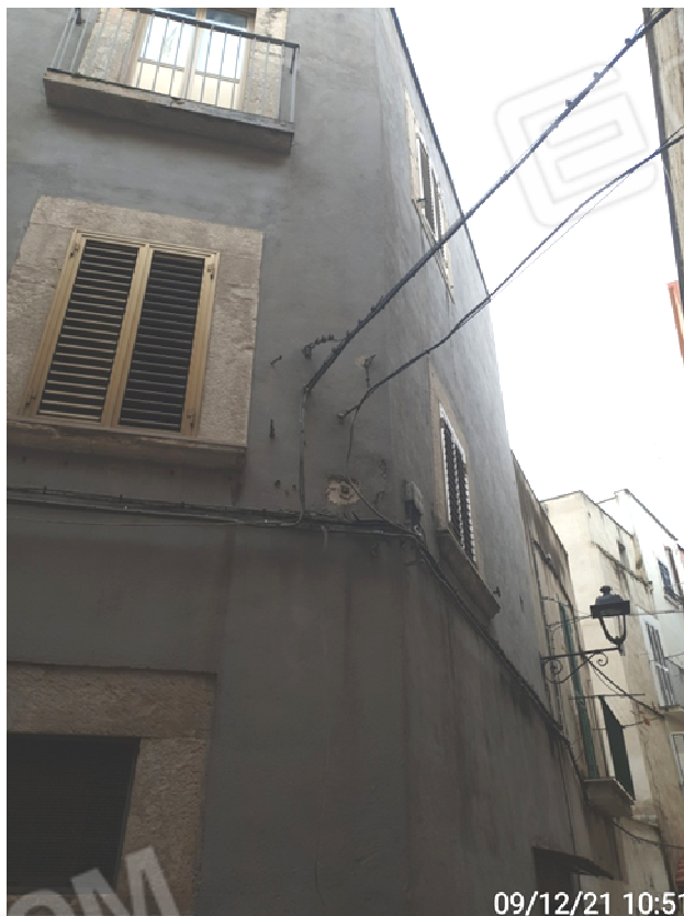
Foto 2 - PROSPETTO VIA PENDILE
