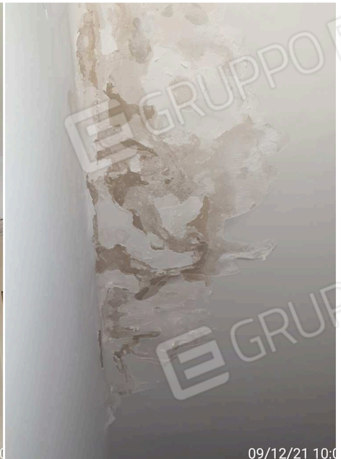
FOTO 15,16: FENOMENO INFILTRATIVO AL SECONDO PIANO
