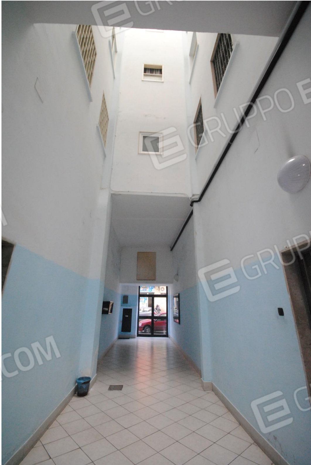
Foto 2: Ripresa dell'androne condominiale.
