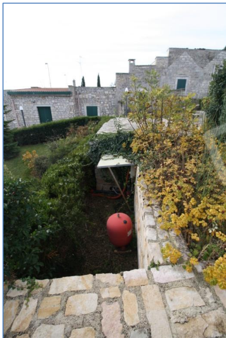
FOTO N.38 CISTERNA DI RACCOLTA ACQUA
