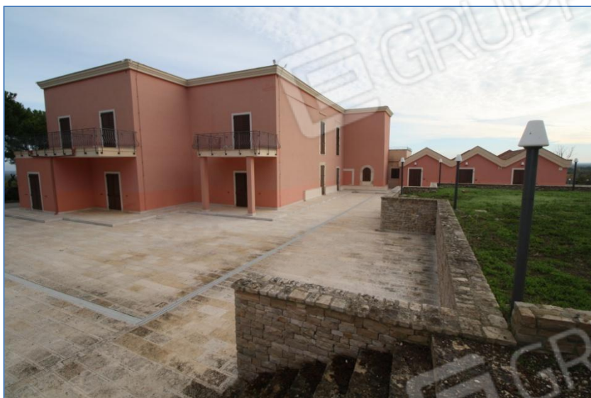
FOTO N.22 VISTA DEI PROSPETTI ESPOSTI AD OVEST
