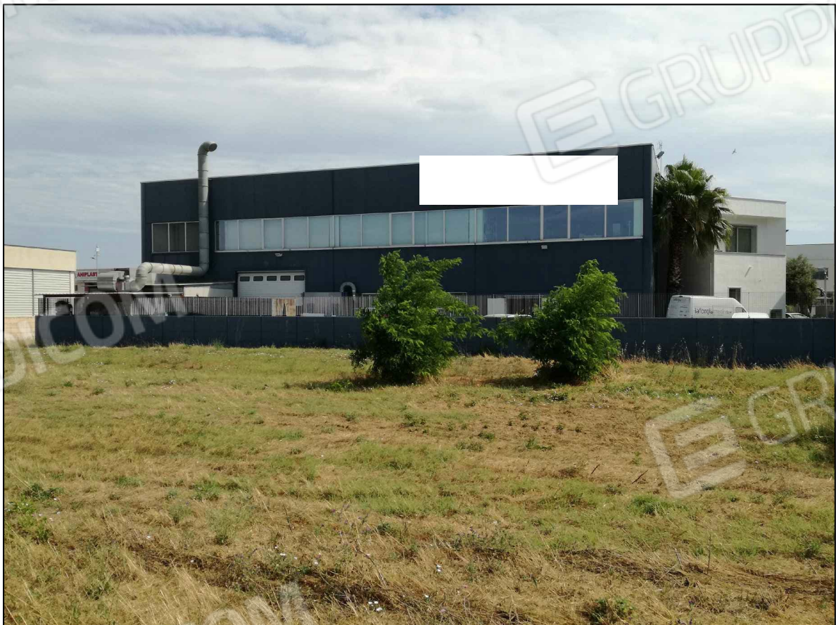
06. Prospetto opposto, vista dalla S.P. 240 (sud-ovest)
