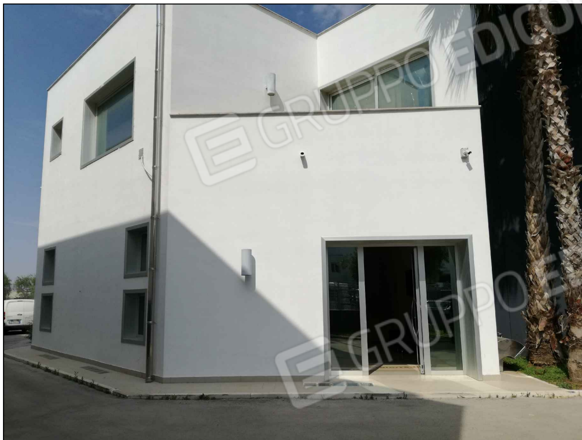
07. Ingresso zona uffici (sud-est)
