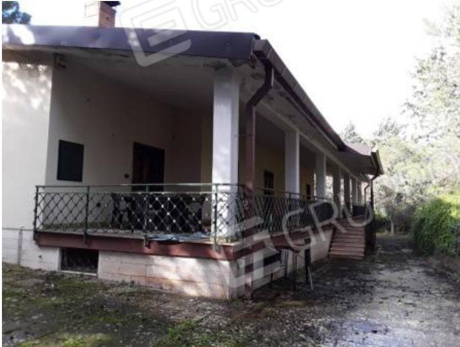
Foto n° 6 : patio con accesso sopraelevato
