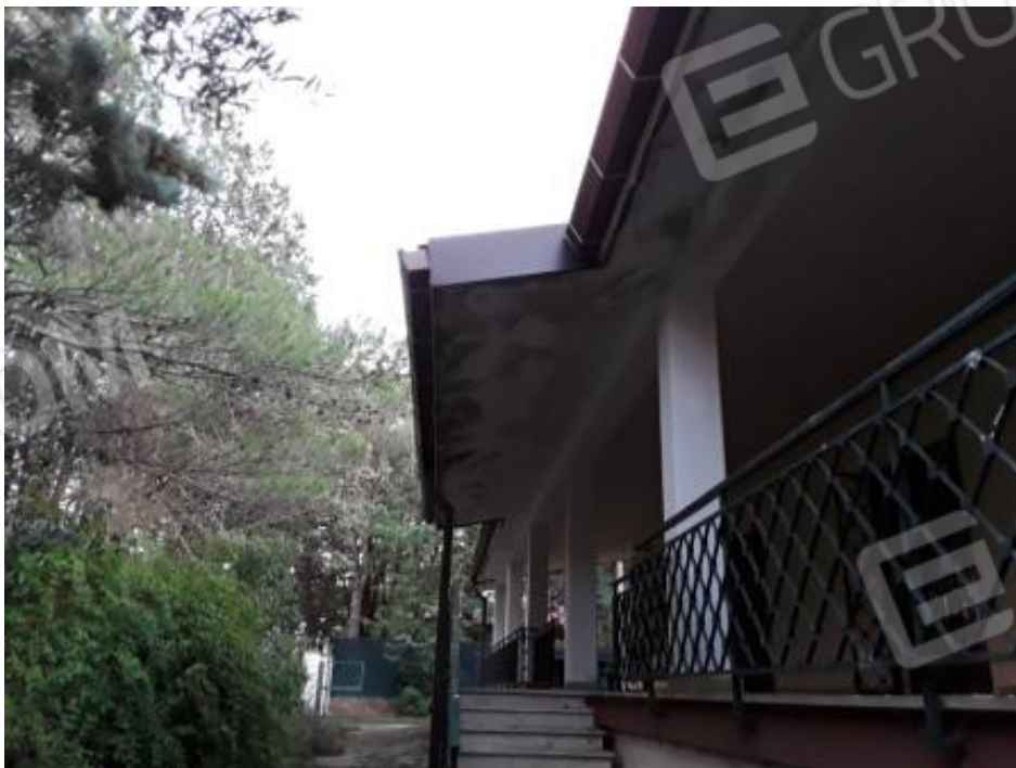
Foto n° 7 : fronte della villa
