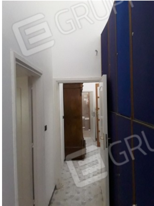
Foto n° 22 : corridoio di collegamento all'unità sub 2
