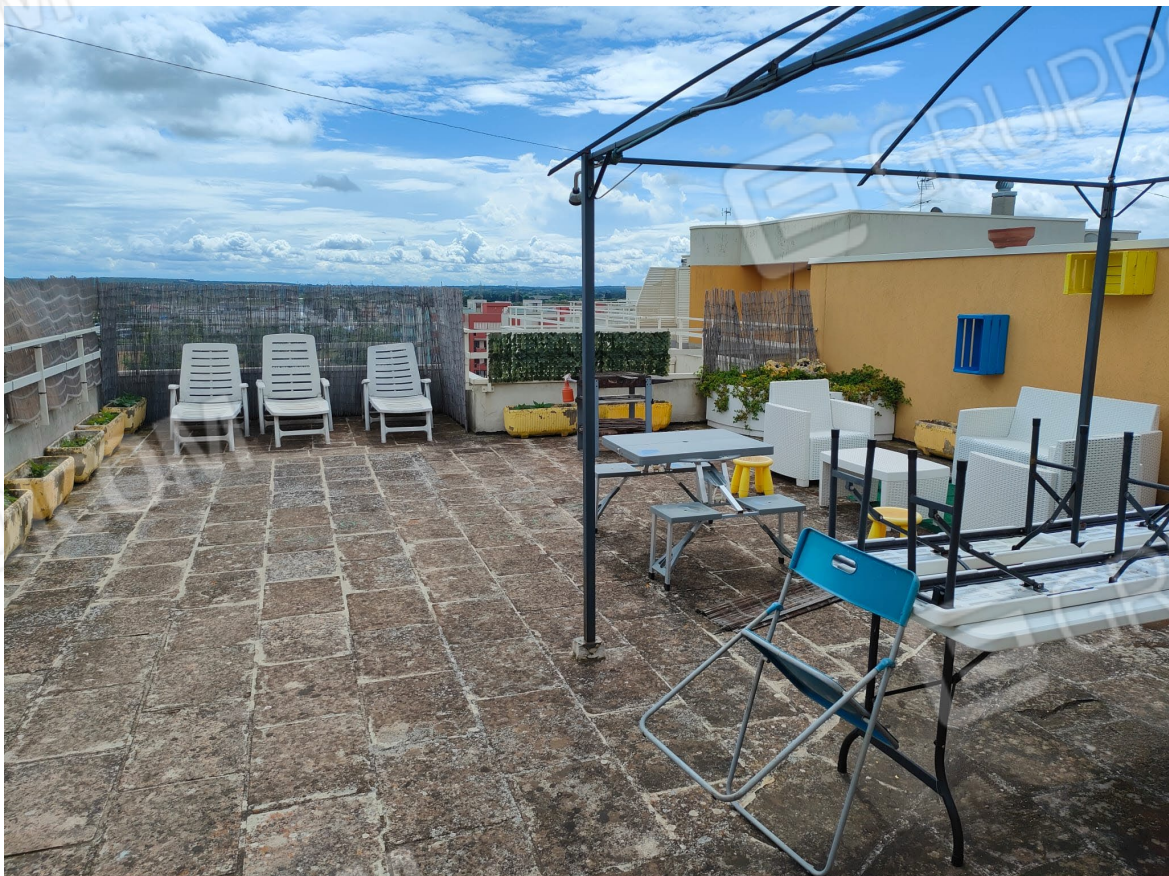
Foto n.14: vista lastrico solare.
