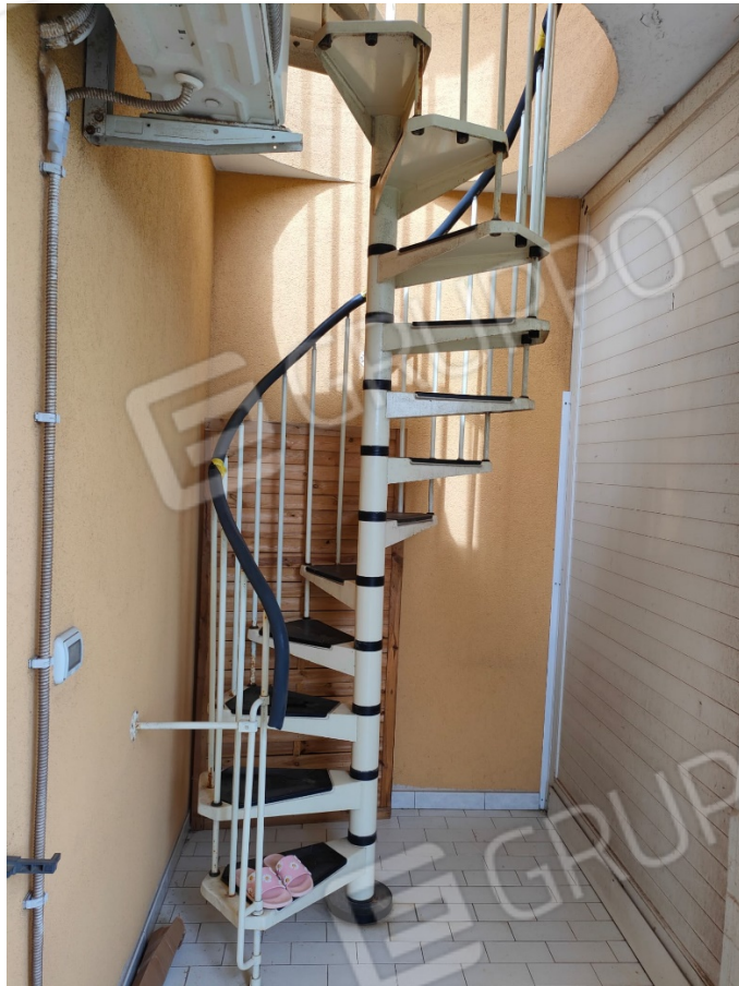
Foto n.13: vista scala esterna.
