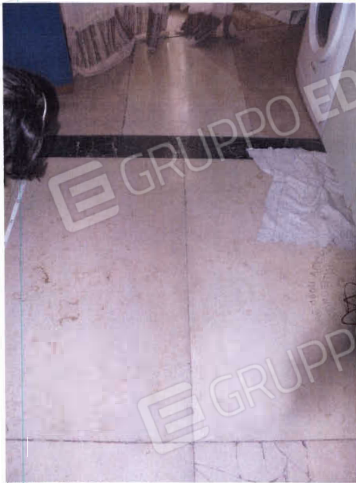
FOTO NN. 9-10: SOGGIORNO-PRANZO PARTICOLARE DELLA PAVIMENTAZIONE IN PIETRA NATURALE(CHIANCHE) (FOTO IN ALTO). PARTICOLARE DELL'ELEMENTO INFISSO IN ANTICORODAL BIANCO (FOTO IN BASSO).
