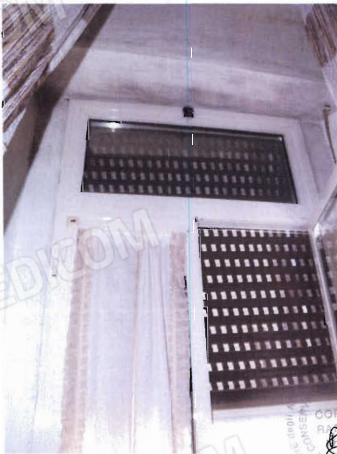
FOTO NN. 9-10: SOGGIORNO-PRANZO PARTICOLARE DELLA PAVIMENTAZIONE IN PIETRA NATURALE(CHIANCHE) (FOTO IN ALTO). PARTICOLARE DELL'ELEMENTO INFISSO IN ANTICORODAL BIANCO (FOTO IN BASSO).
