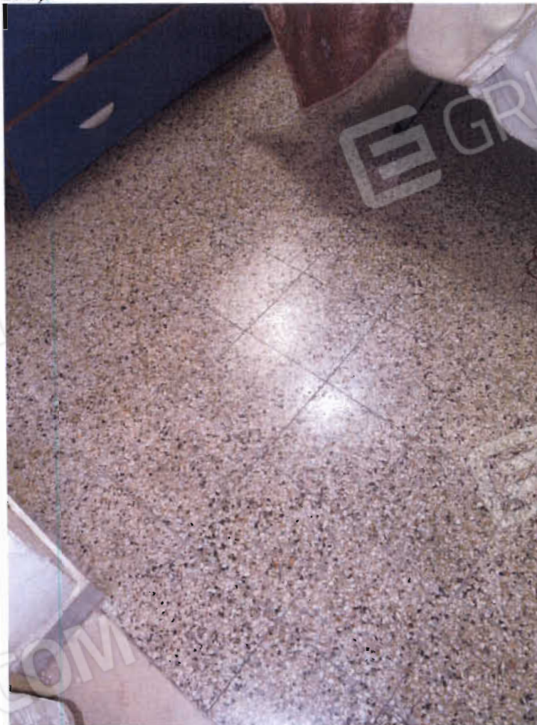
FOTO NN. 23-24: CAMERA DA LETTO MATRIMONIALE: PARTICOLARE DELLA VOLTA DI COPERTURA E DEL LUCERNARIO (FOTO IN ALTO). PARTICOLARE DELLA PAVIMENTAZIONE IN GRANIGLIATO DI CEMENTO (FOTO IN BASSO).
