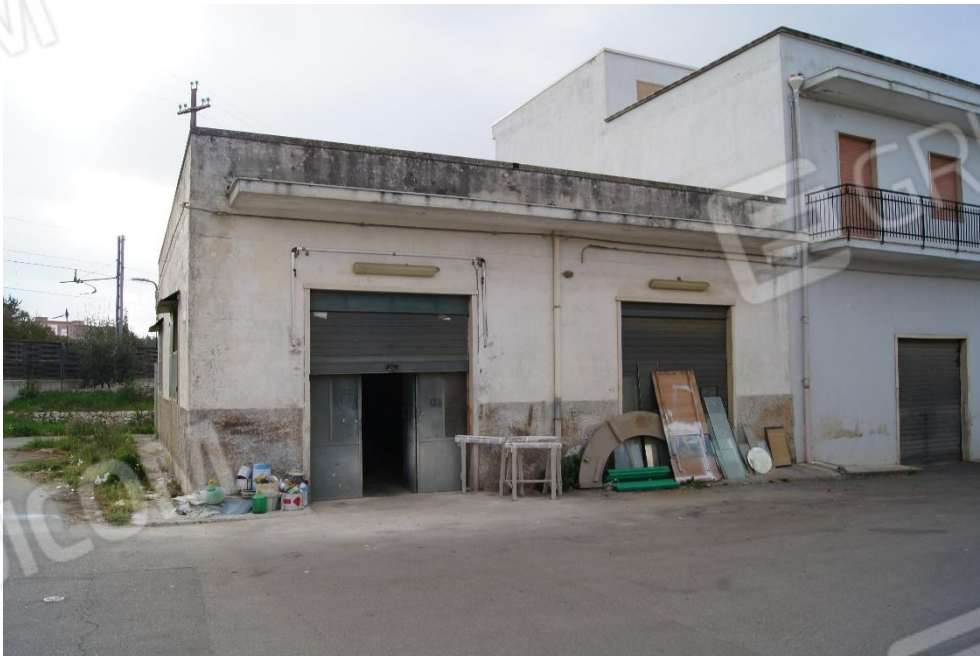
Foto 4: prospetto lato ovest
