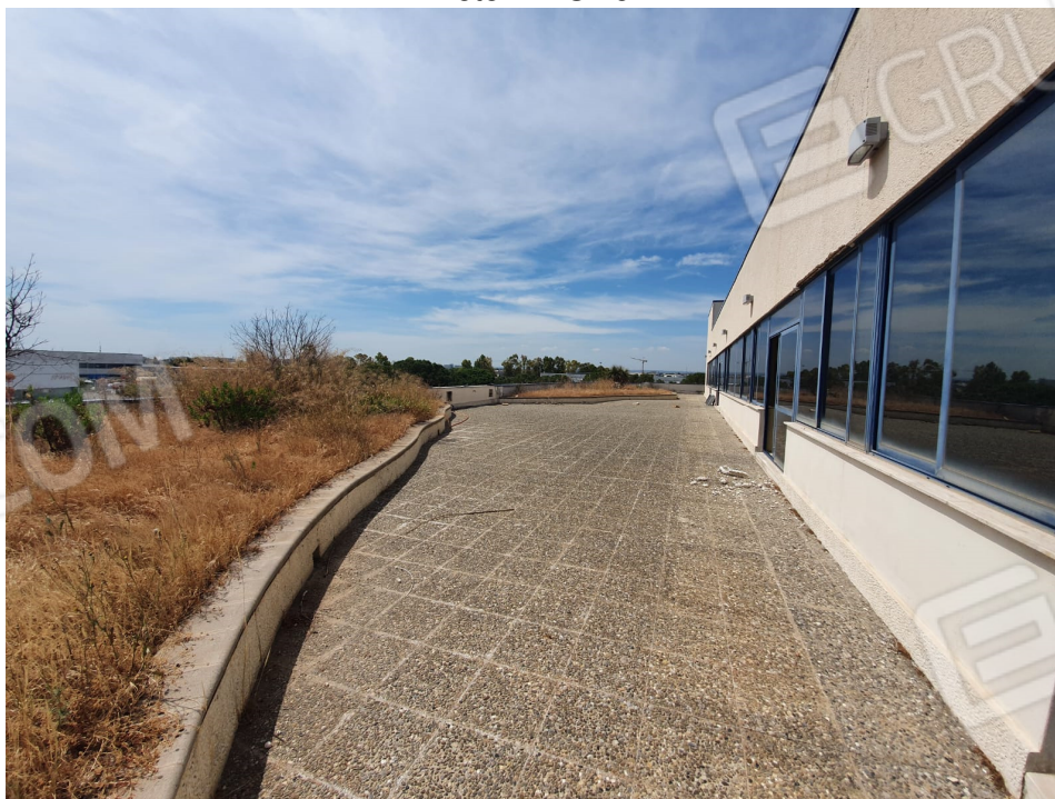
Foto 12: Terrazza cortile interno
