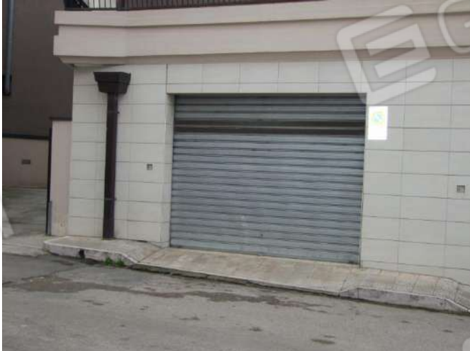
Foto 180 – Vista esterna della saracinesca di ingresso al locale.
