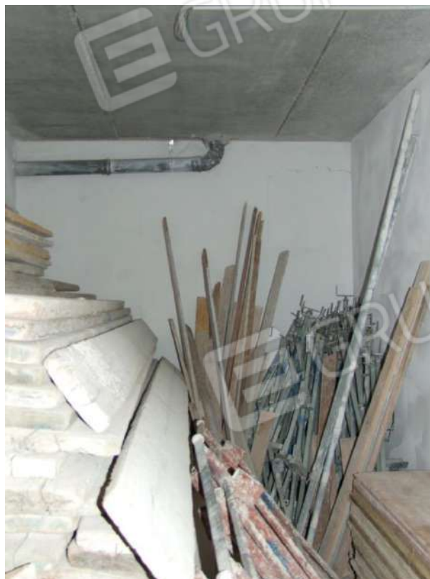
Foto 192 – Vista interna del locale. Particolare tubazione di scarico idrico - fognario.
