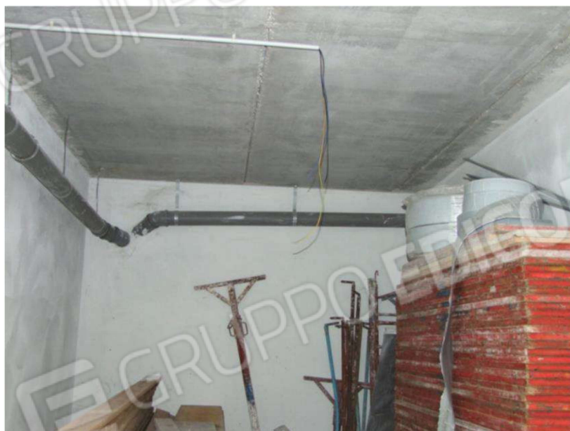
Foto 190 – Vista interna del locale. Particolare tubazione di scarico idrico - fognario.
