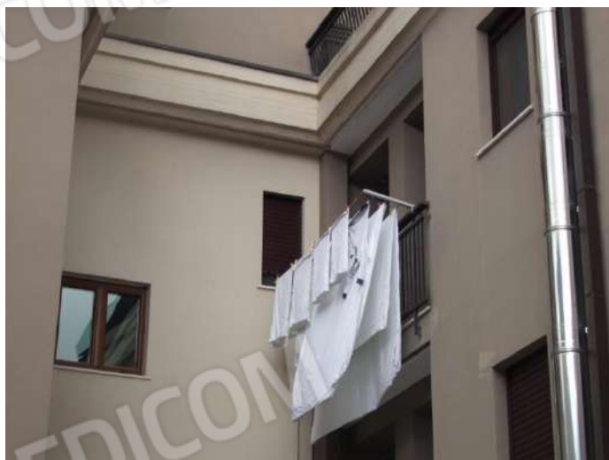
Foto 153 – Vista della loggia al 2° piano del prospetto posteriore affacciante sullo spazio interno condominiale.
