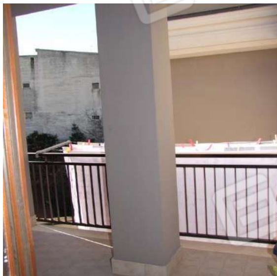
Foto 166 – Vista della loggia al prospetto posteriore.
