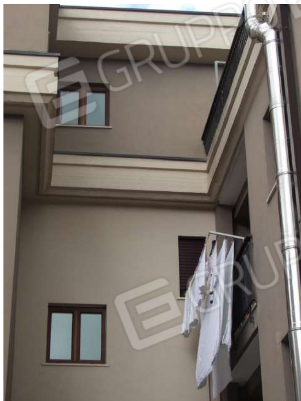
Foto 154 – Vista del prospetto posteriore. Particolare loggia al 2° Piano.
