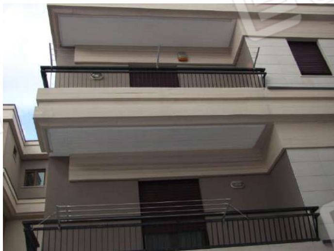
Foto 152 – Vista del balcone al prospetto laterale affacciante sullo spazio interno condominiale.
