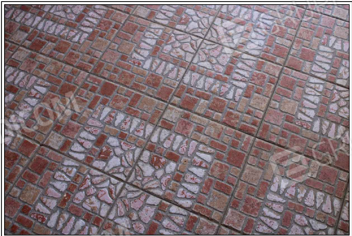
FOTO N° 48 - PARTICOLARE PAVIMENTO VERANDA
