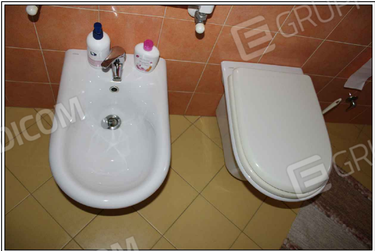
FOTO N° 56 - PARTICOLARE SANITARI BAGNO
