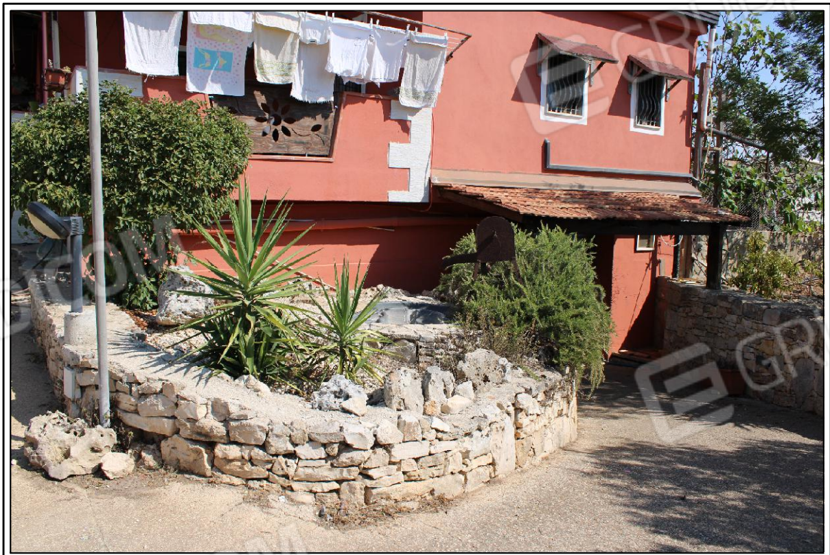
FOTO N° 4 - PARTICOLARE PROSPETTO E ACCESSO PIANO S1
