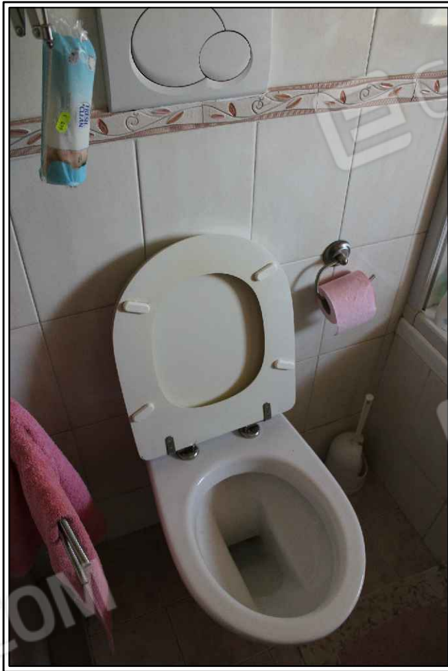
FOTO N° 58 - PARTICOLARE SANITARI W.C. 1
