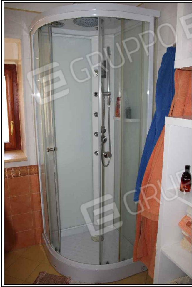
FOTO N° 57 - PARTICOLARE DOCCIA IDROM. BAGNO
