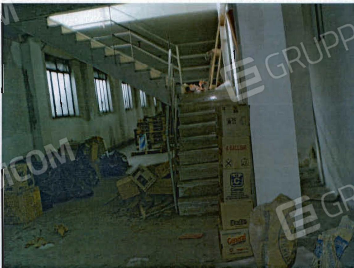
Foto 02 – scala di accesso al locale deposito
