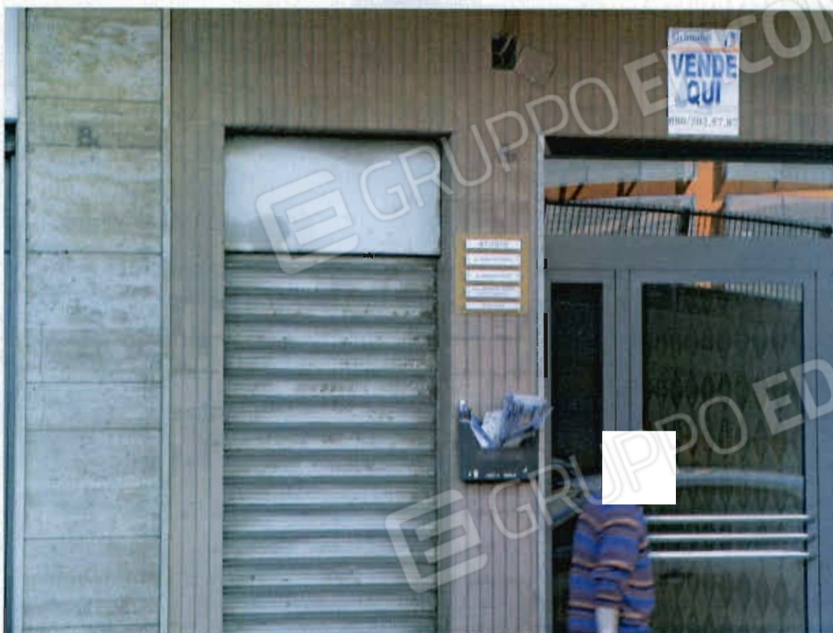
Foto 01 – accesso al locale deposito
