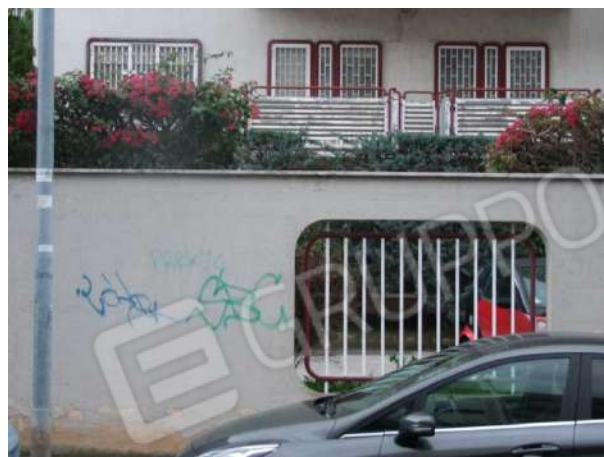
Foto 8 – Prospetto anteriore – Particolare portefinestre del Bene
