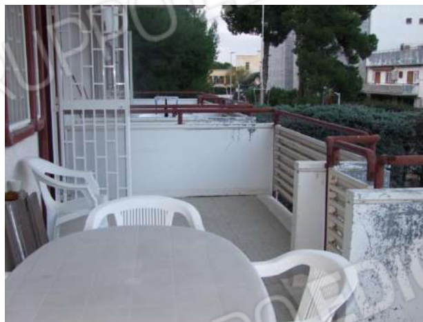
Foto 30 – Vista verso il lato Nord - Ovest
