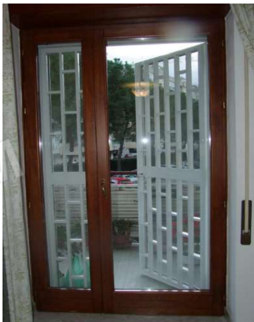
Foto 41 e 42 – Particolare infissi esterni
