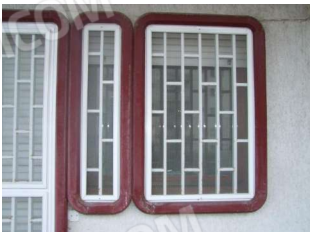
Foto 43 – Particolare infisso esterno – vista esterna
