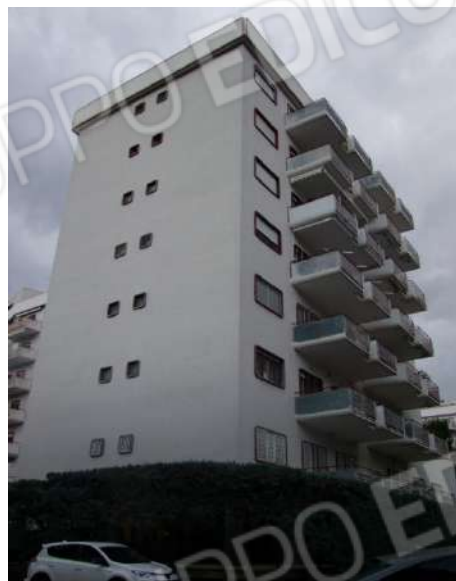
Foto 6 – Vista angolare del prospetto anteriore e laterale
