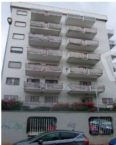
Foto 5 – Prospetto anteriore sulla via R. Schuman
