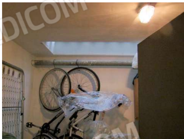
Foto 47 - Vista interna - Particolare lucernario al soffitto
