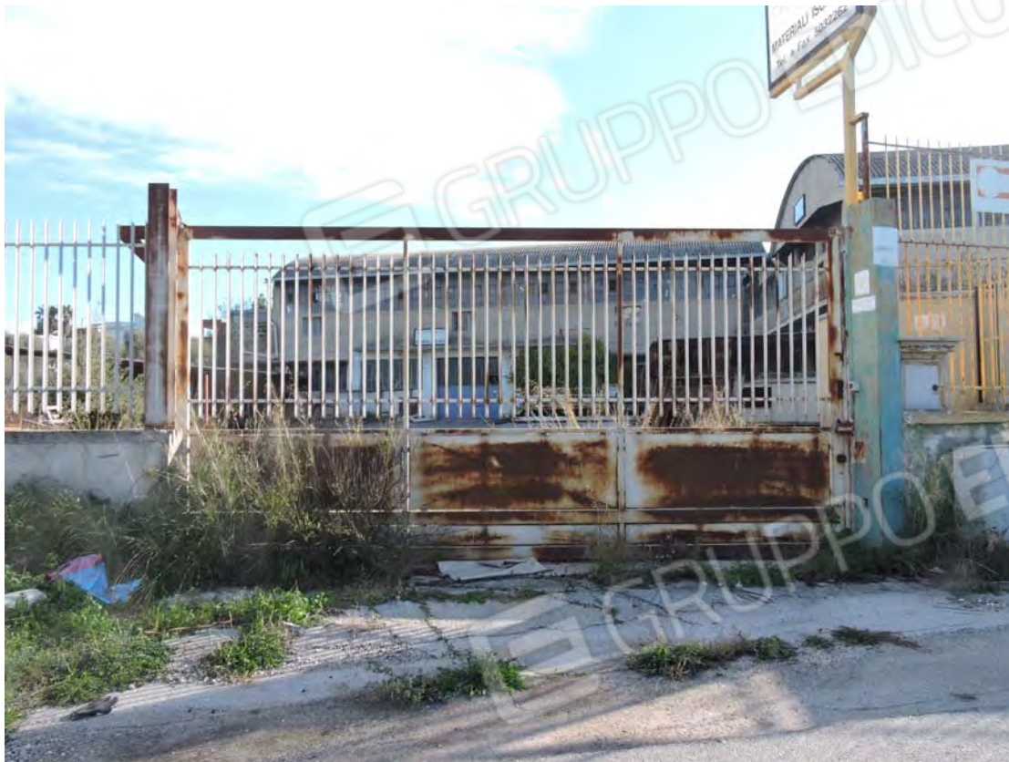
Accesso – strada Fondo Capillo del Campo
