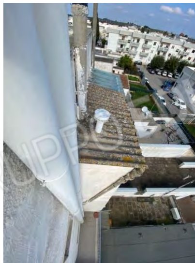
Coperture manufatti sul balcone interno, foto 2
