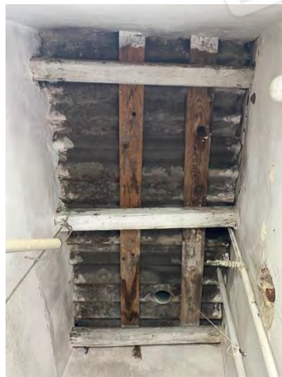
copertura il lastre di fibrocemento su travi e travetti di legno, sul ripostiglio
