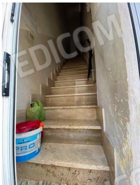
La prima rampa di accesso ai piani
