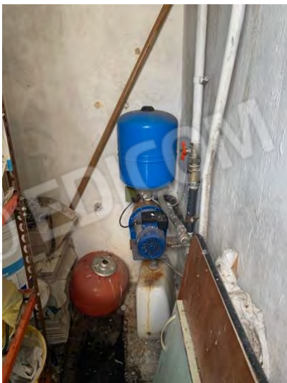
Pompa autoclave autonoma nel ripostiglio prima citato
