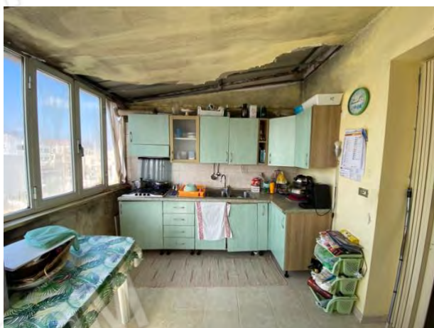
la cucina attuale in veranda non autorizzata, foto 2
