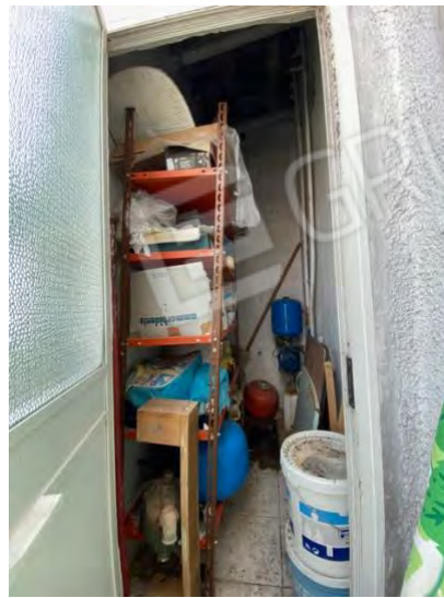
Ripostiglio su balcone non previsto in progetto ma accatastato; vista da veranda non autorizzata
