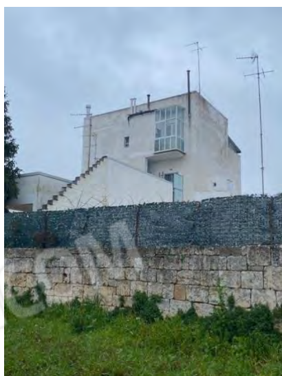
L'edificio, visto da una strada posteriore; si notano le due verande non autorizzate, sul fronte e sul retro
