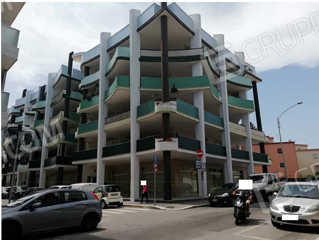
Prospetto del fabbricato
