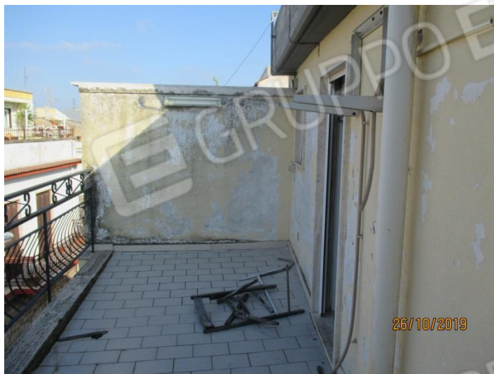
Foto n. 19 - Terrazza al piano secondo
