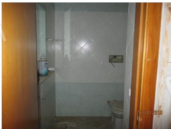
Foto n. 9 - Bagno al piano primo
