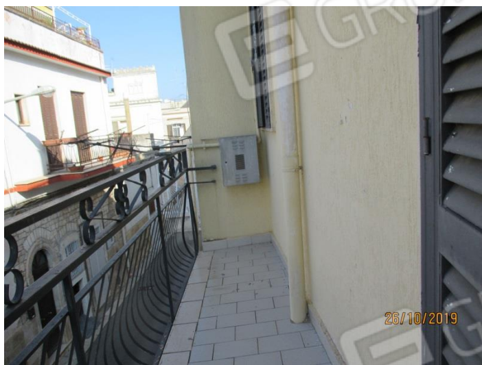
Foto n. 11 - Balcone al piano primo
