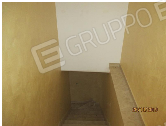
Foto n. 13 - Vano scala di accesso al piano secondo
