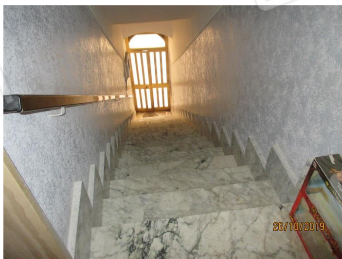
Foto n. 3 - Ingresso vano scala da piano primo
