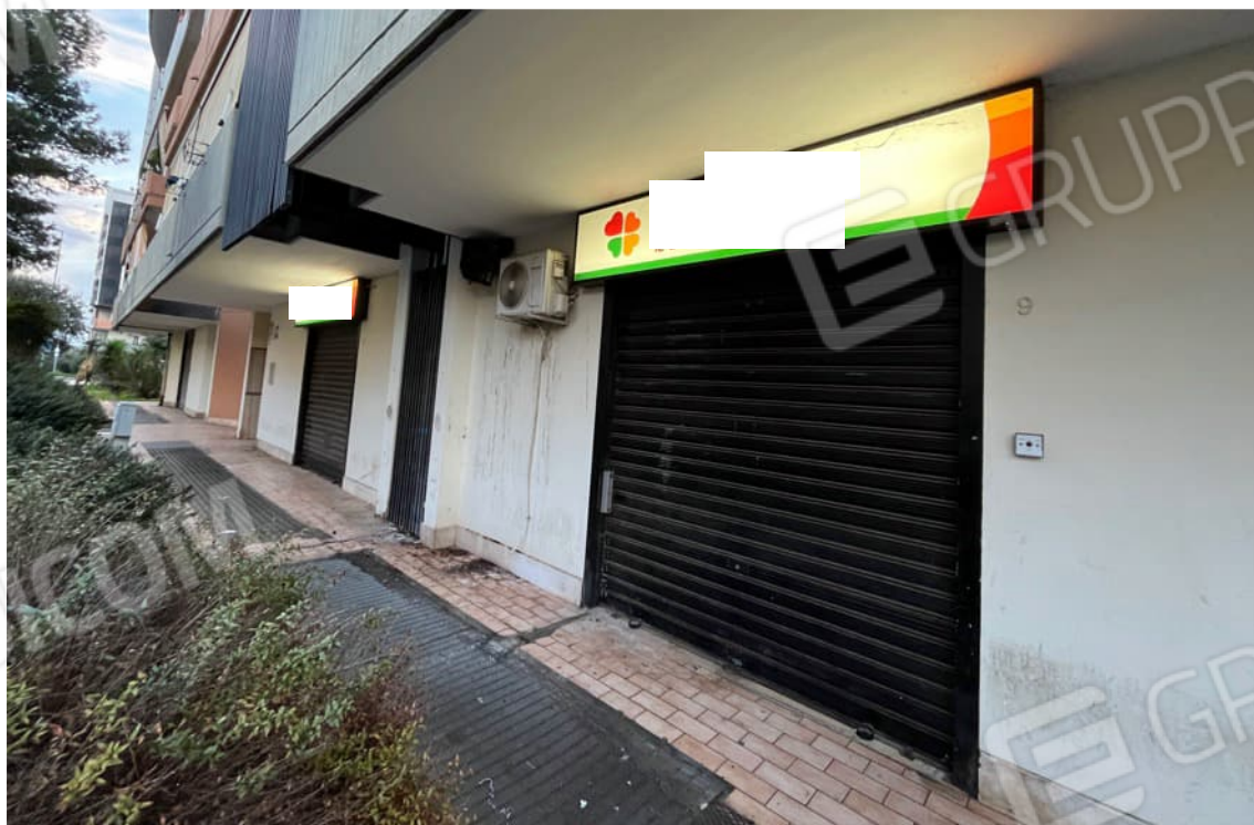
Fig.2 – Vista delle luci d'ingresso, civv.9-11, al locale commerciale su via F. Del Core
