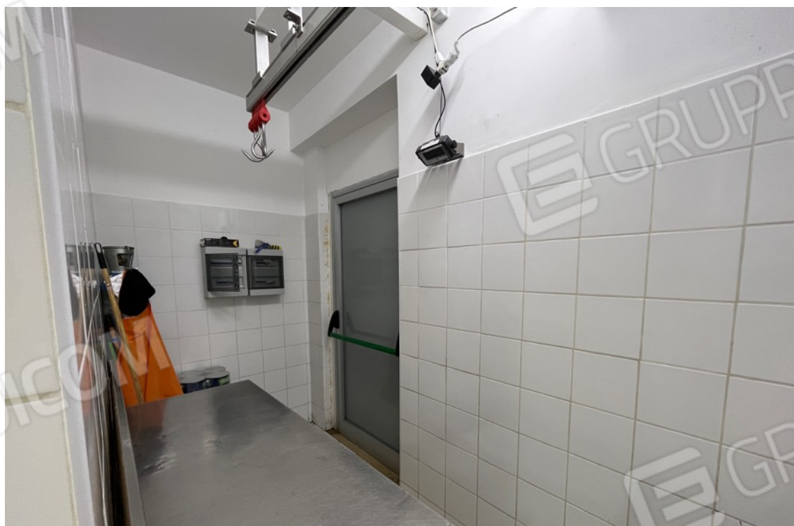
Fig.10 – Vista su laboratorio di lavorazione carni al civ.9 (sub.28)
