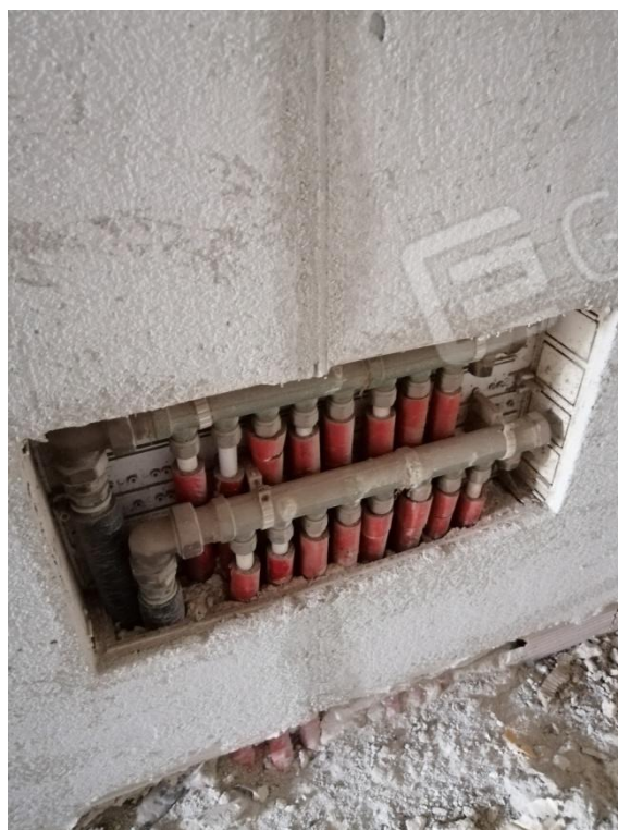
Foto 20 - Vista del collettore dell'impianto termico (p1)
