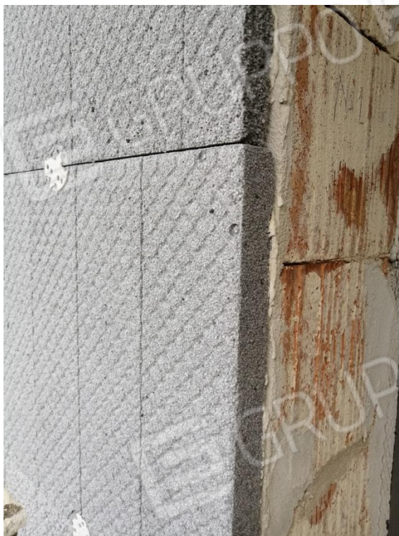
Foto 25 – Dettaglio del cappotto esterno dell'involucro non completato (p1)
