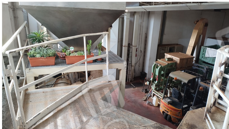
Foto n.8: Locale a piano seminterrato
