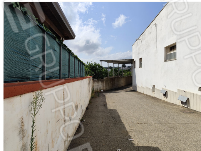
Foto n.14: Rampa di accesso laterale
