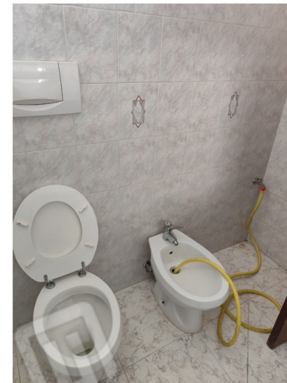
Foto n.7: Locale a piano terra - servizi
