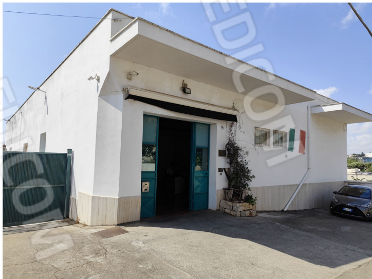
Foto n.1: Prospetto esterno su via Tratturo Fanelli
