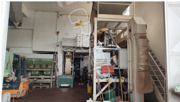
Foto n.9: Locale a piano seminterrato
