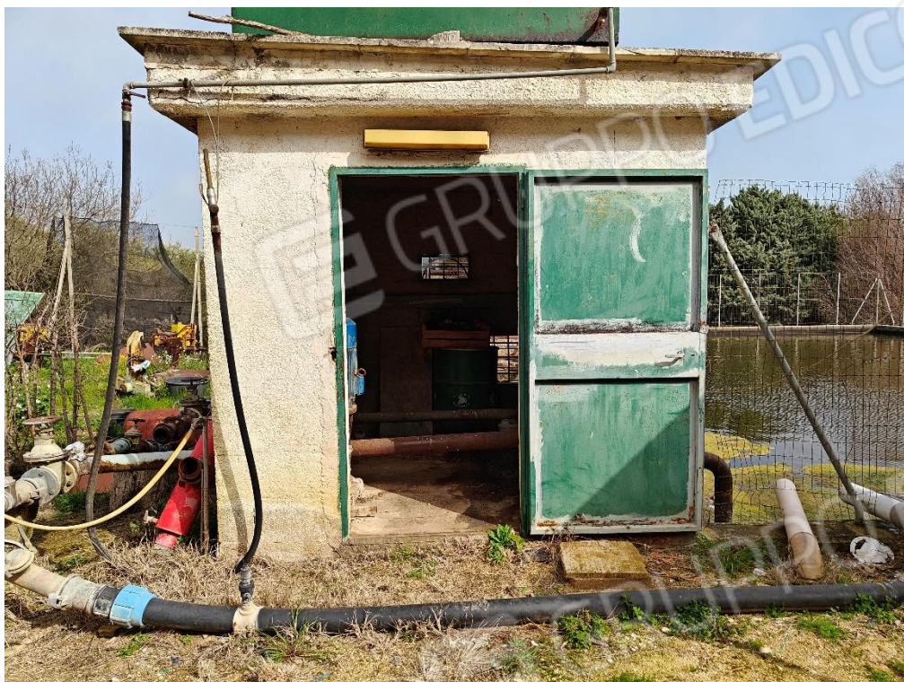
Immagine 11: Locale per le pompe per irrigazione e prelievo dalla vasca dell'acqua per irrigazione
