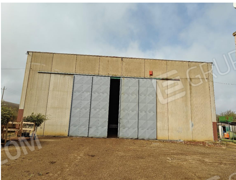
Immagine 6: Vista esterna del capannone ricovero attrezzi e macchine agricole di superficie circa 400 m 2
