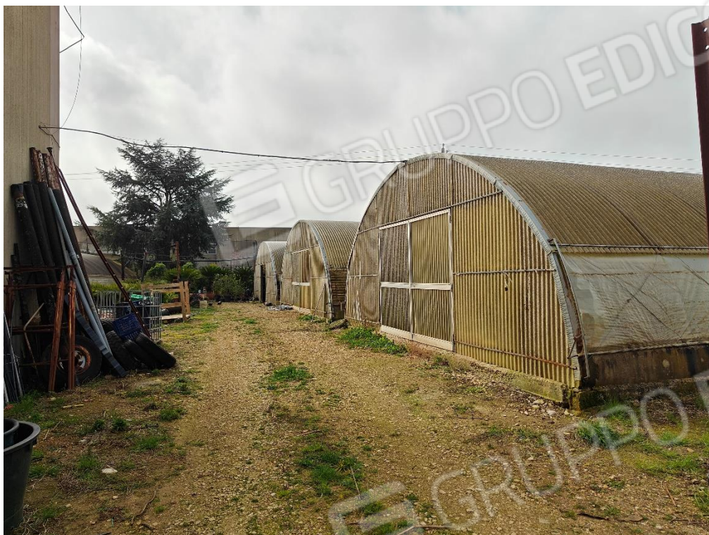
Immagine 13: Tunnel con struttura metallica ad arco coperti con lastre di vetroresina per la coltivazione delle piante
