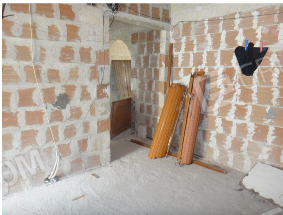
Foto n°12 – Vista dell'accesso dalle scale alla stanza n°3
