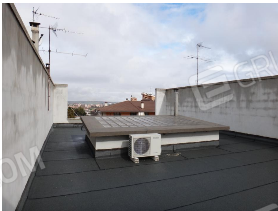
Foto n°14 – Altra vista del lastrico solare
