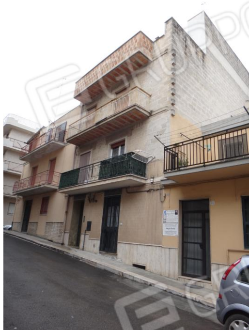
Foto n°1 – Vista del fabbricato cui l’immobile de quo appartiene da via Terlizzi
