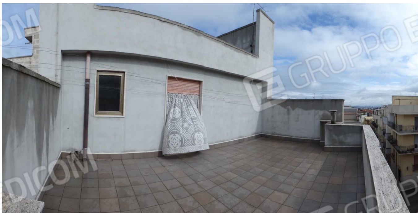
Foto n°10 – Vista della terrazza n°2
