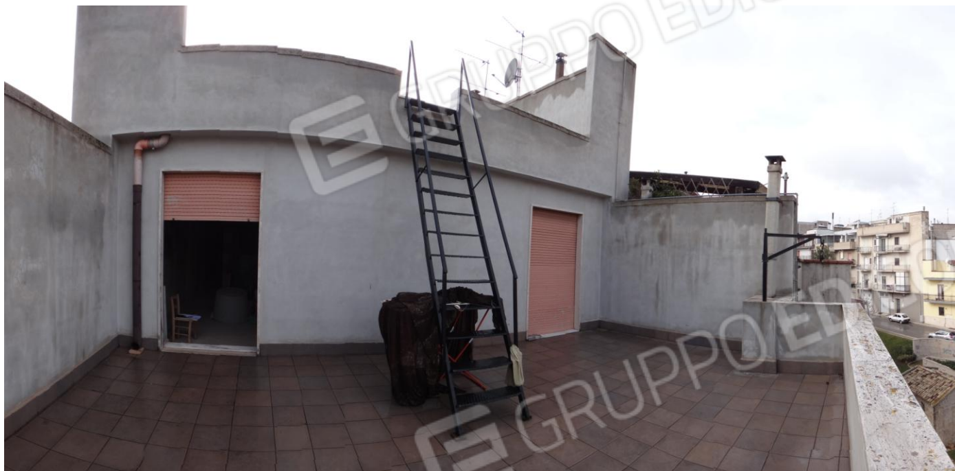
Foto n°7 – Vista della terrazza n°1
