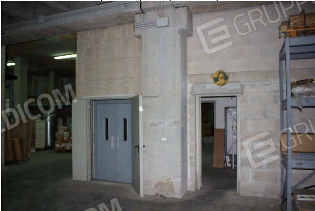
Foto 42 (Vista del deposito al piano interrato)
