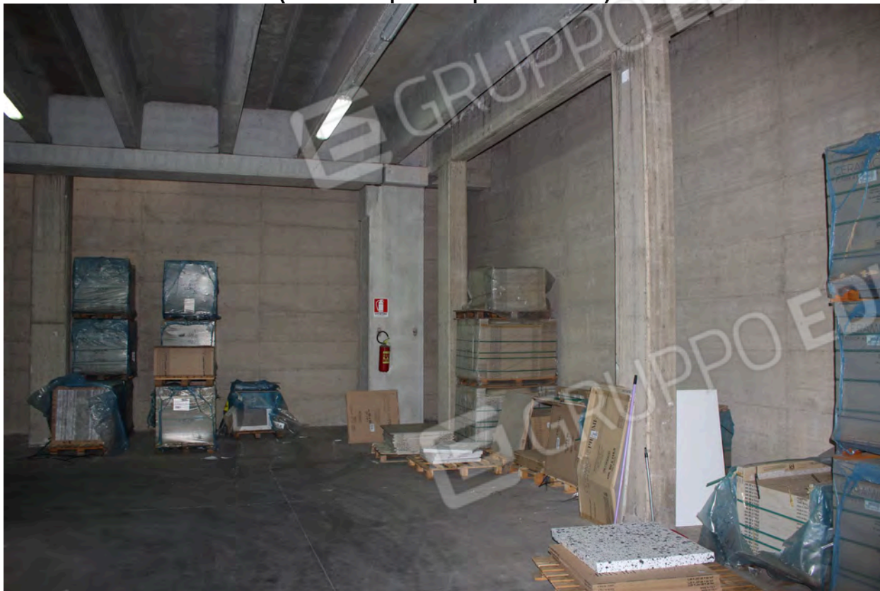
Foto 39 (Vista del deposito al piano interrato)
