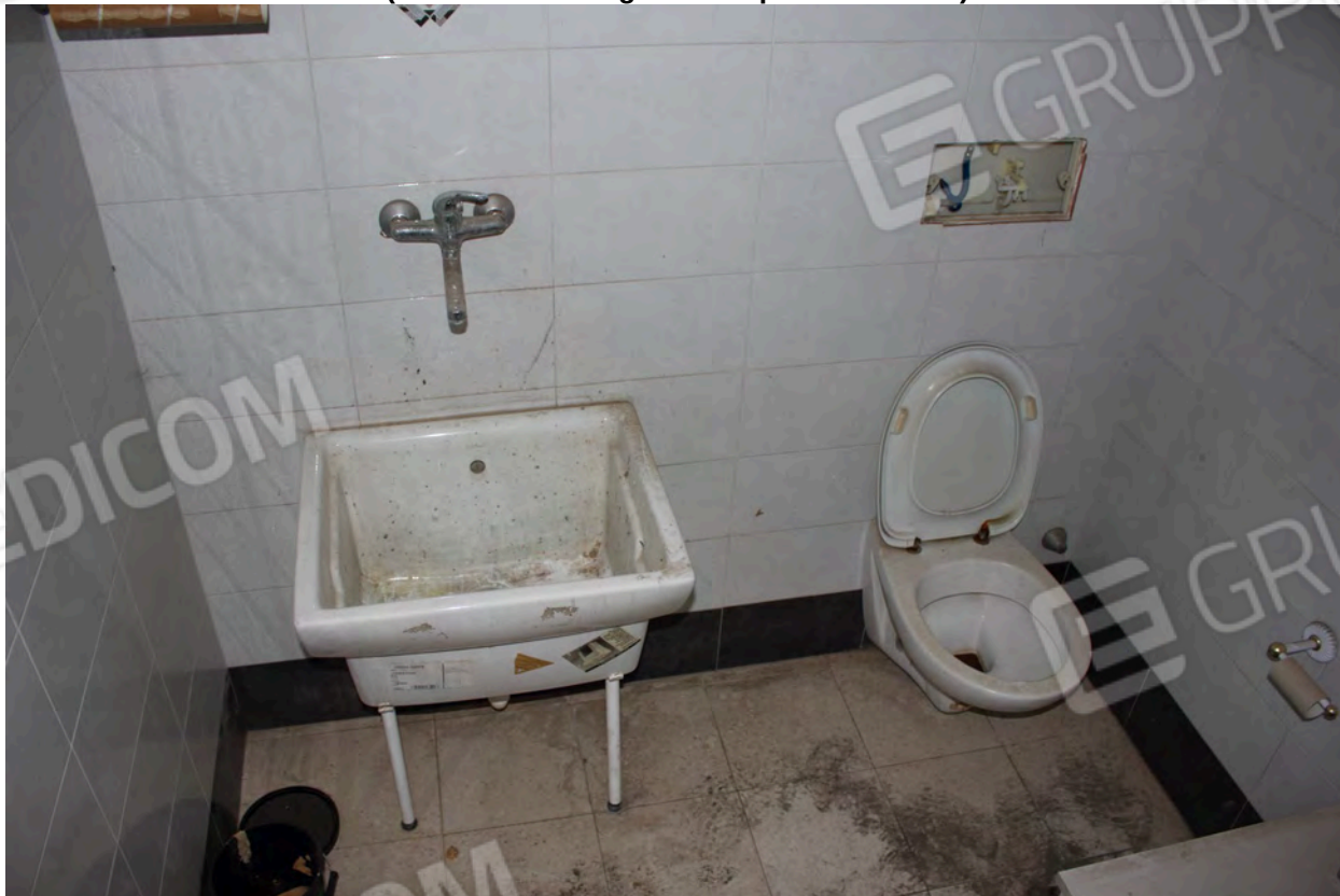
Foto 46 (Vista del locale igienico al piano interrato)
