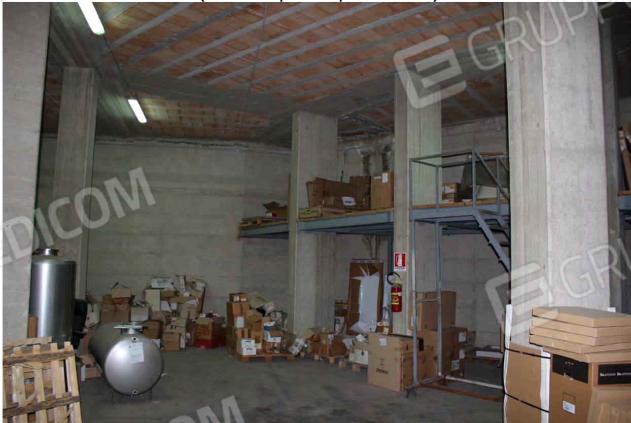
Foto 44 (Vista del deposito al piano interrato)
