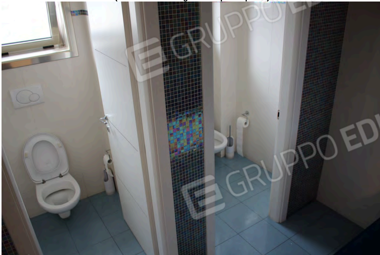
Foto 31 (Vista dei servizi igienici al primo piano)
