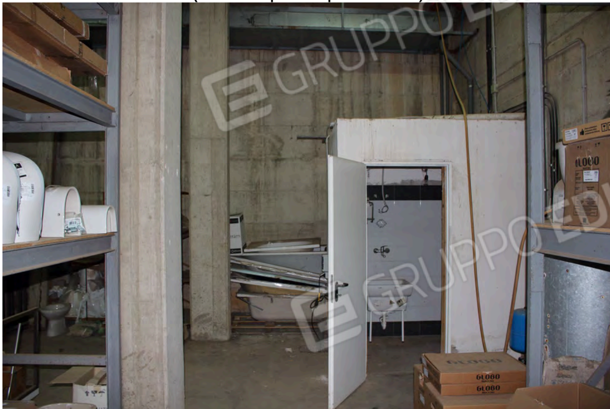
Foto 45 (Vista del deposito al piano interrato)
