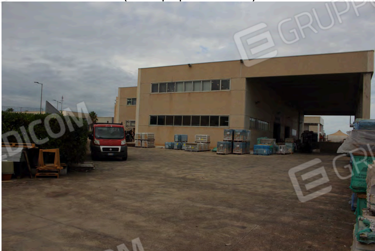
Foto 4 (Vista del prospetto e della tettoia)
