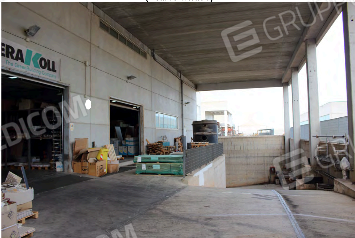
Foto 6 (Vista della tettoia)
