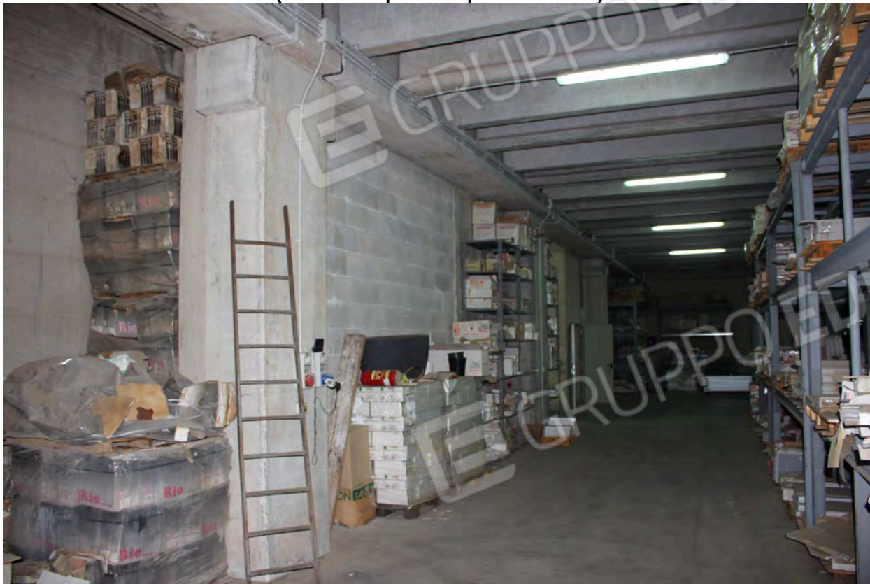
Foto 41 (Vista del deposito al piano interrato)
