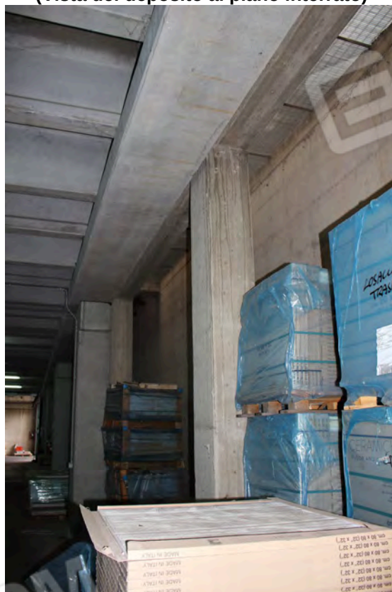
Foto 40 (Vista del deposito al piano interrato)
