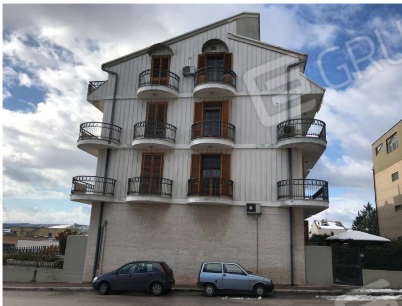
Foto 2 - Vista del prospetto laterale prospiciente via E. Montale
