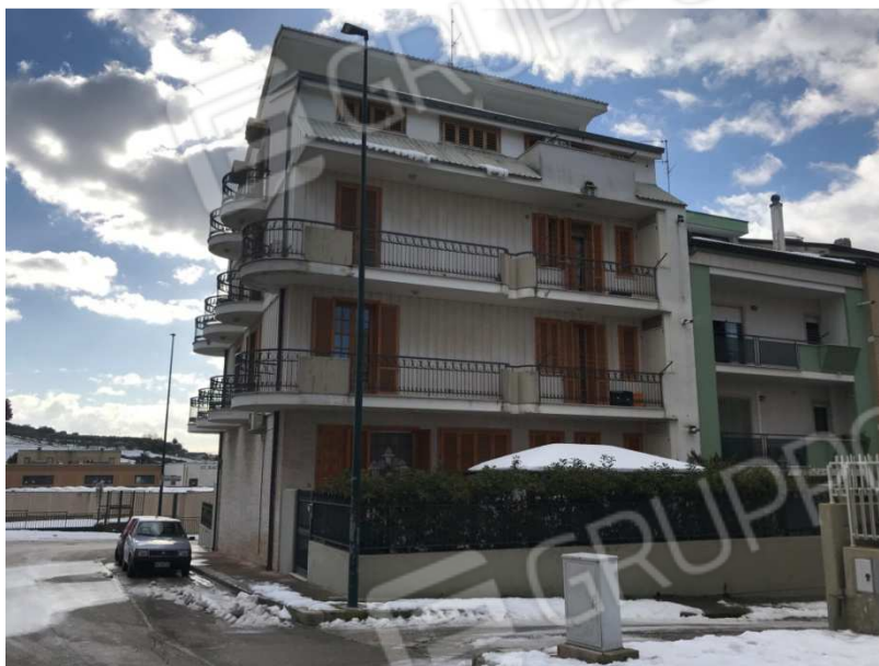
Foto 3 - Vista del prospetto posteriore prospiciente via C. Rebora
