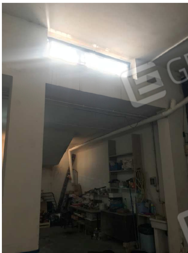
Foto 16 - Vista dell'autorimessa pertinenziale al secondo piano interrato
