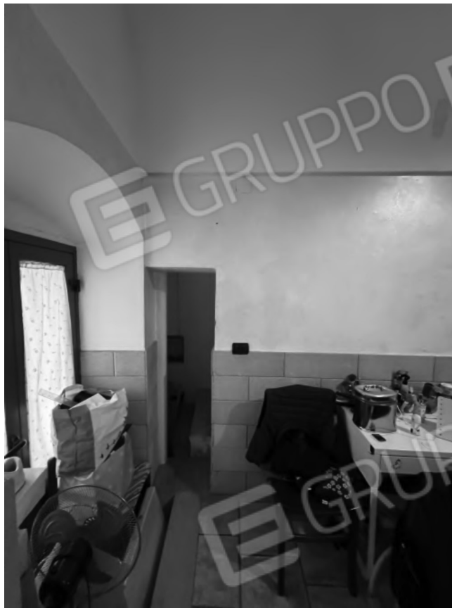
Figura 6: Piano rialzato – varco verso vano scale
