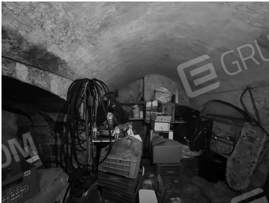
Figura 13: deposito piano interrato
