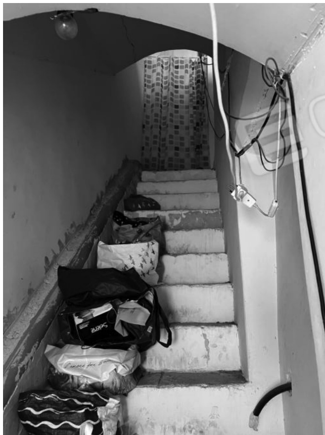
Figura 9: Vano scale collegamento piano primo - piano secondo
