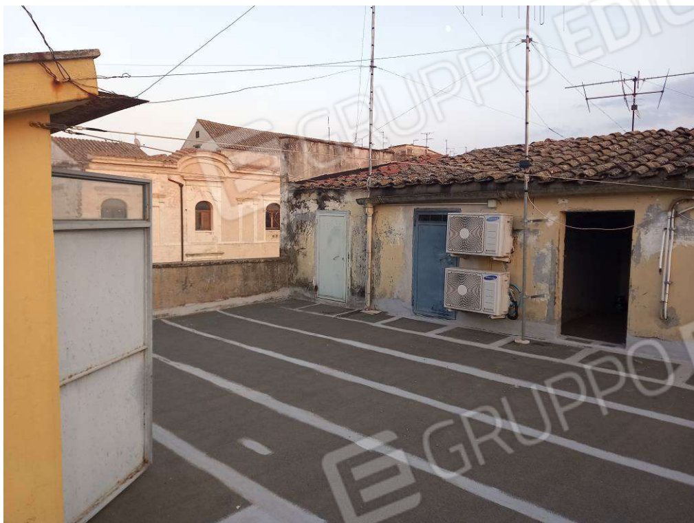
FOTO 37: Terrazza condominiale vista verso le soffitte al III piano
