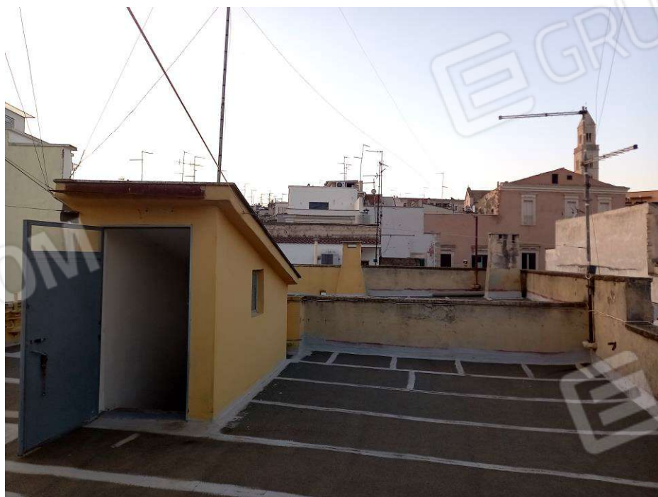
FOTO 36: Vista Terrazza condominiale con il torrino scala
