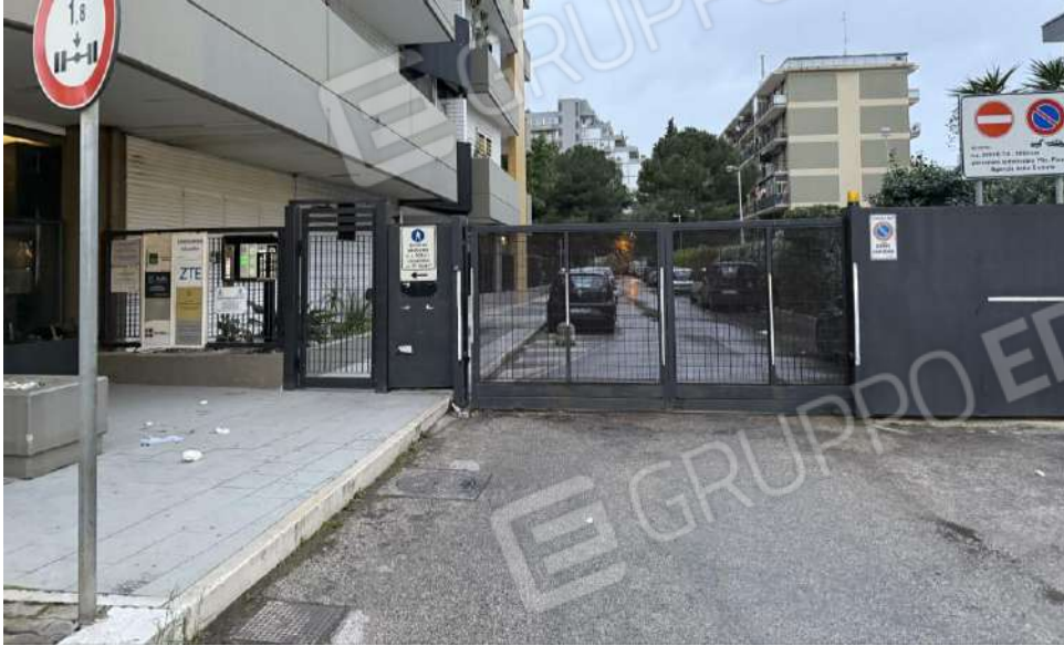
FOTO 1 Cannello di ingresso su strada
