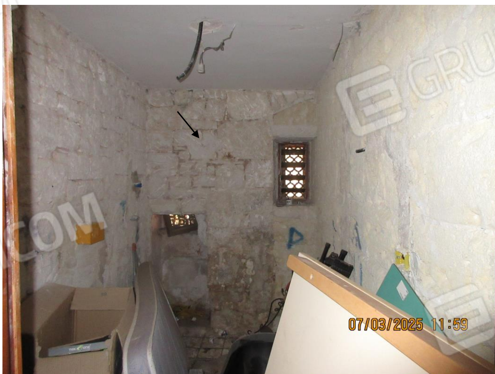
Foto n.8 Unico Bagno con la parete frontale prospiciente la Via Doria
