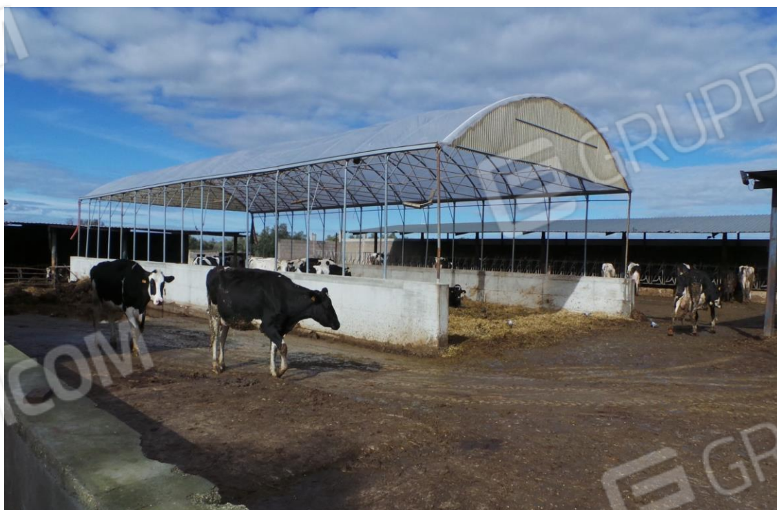
Foto 4 – Visione prospettica allevamento bovini e tettoie
