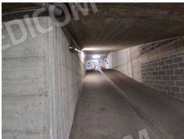
Vista della Rampa dal piano 2° interrato dei Box
