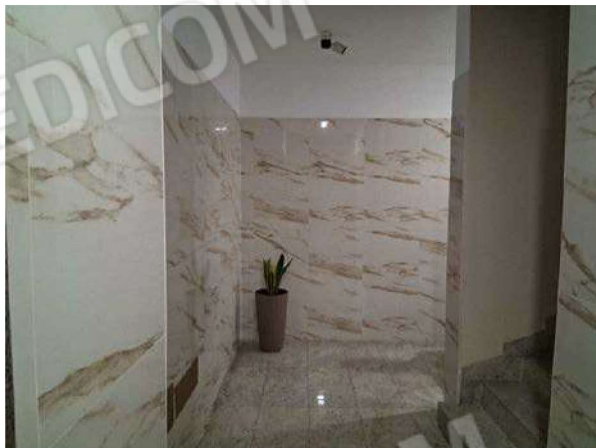
Vista interna pianerottolo Ascensori al Piano Terra
