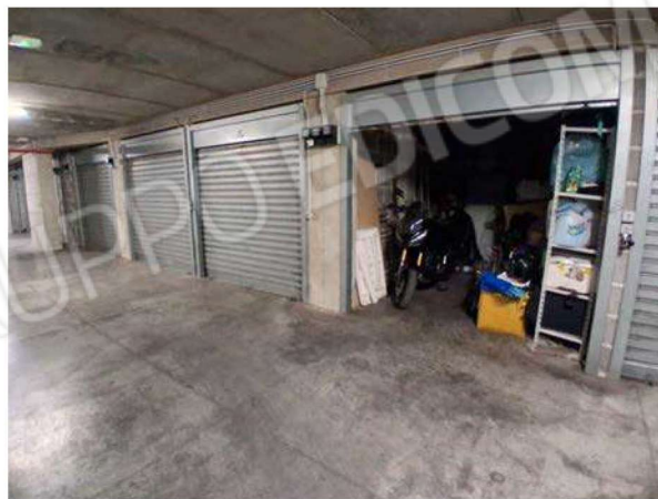
Vista della Corsia di Manovra e dell'ingresso al Box
