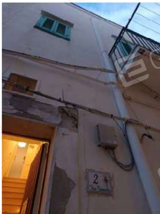
Foto 11 – prospetto su via Tatanello
