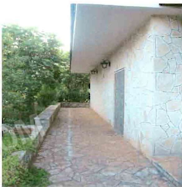
Prospetto principale con pensilina, e muretti
