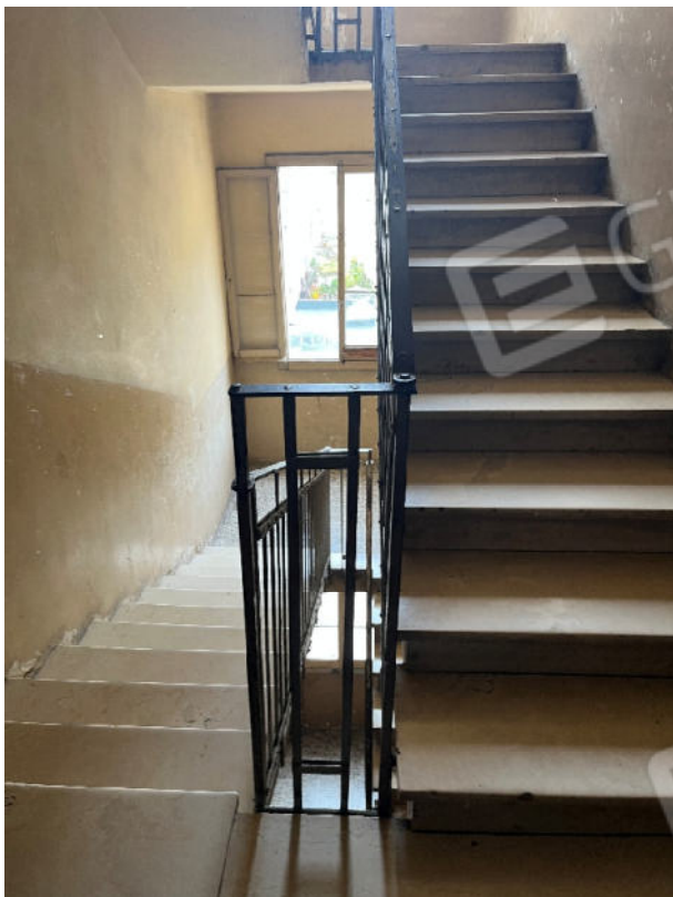
Vano scala condominiale
