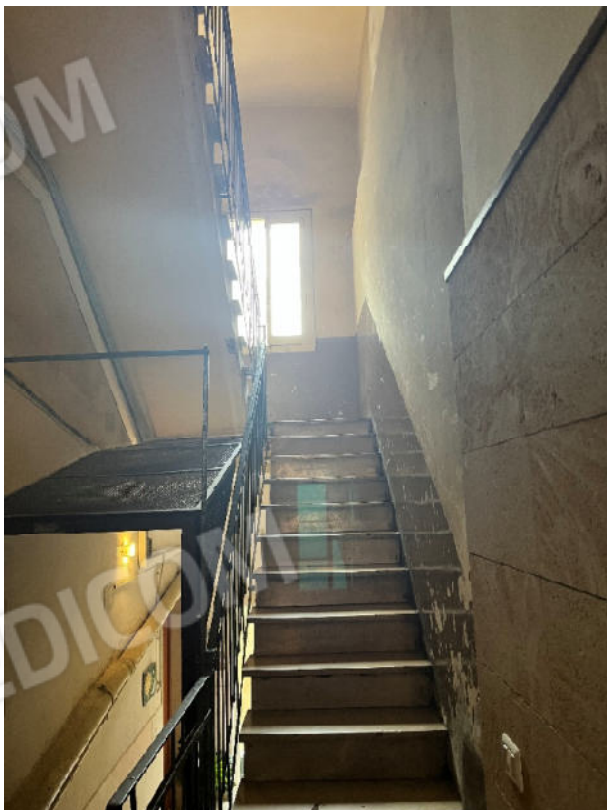
Vano scala condominiale
