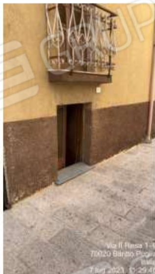
Foto N. 89,...97 – Immobile 1) via Prima Resa in Bitritto (BA)
