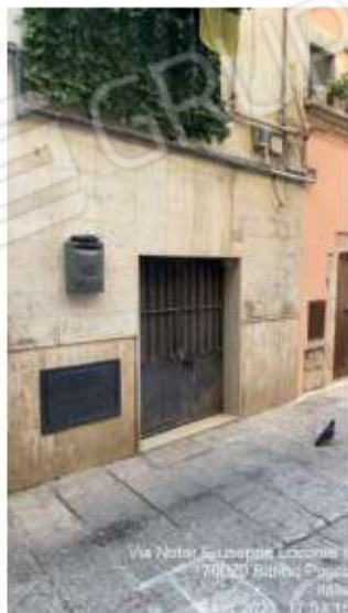
Foto N. 98,...., 103 - Immobile 2) via Loconte 5 in Bitritto (BA)
