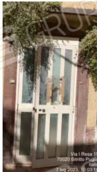
Foto N. 5....88 – Immobili 4) , 5) e 6) via Prima Resa in Bitritto (BA)
