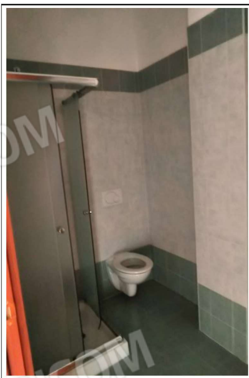
Bagno di servizio
