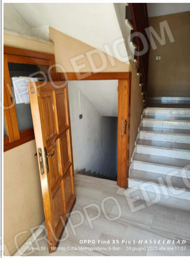
Ingresso al locale deposito dall'androne scale
