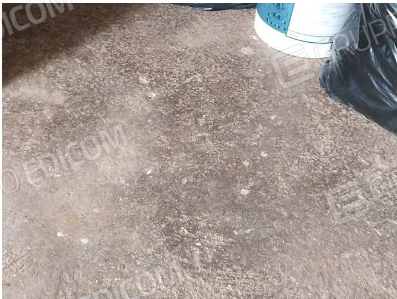
FOTO NN. 28-29: DEPOSITO LAVANDERIA A PIANO TERRA (FOTO IN ALTO);PARTICOLARE DELLA PAVIMENTAZIONE IN BATTUTO DI CEMENTO (FOTO IN BASSO)
