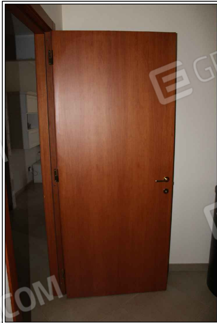
FOTO N° 54 - PARTICOLARE PORTE INTERNE
