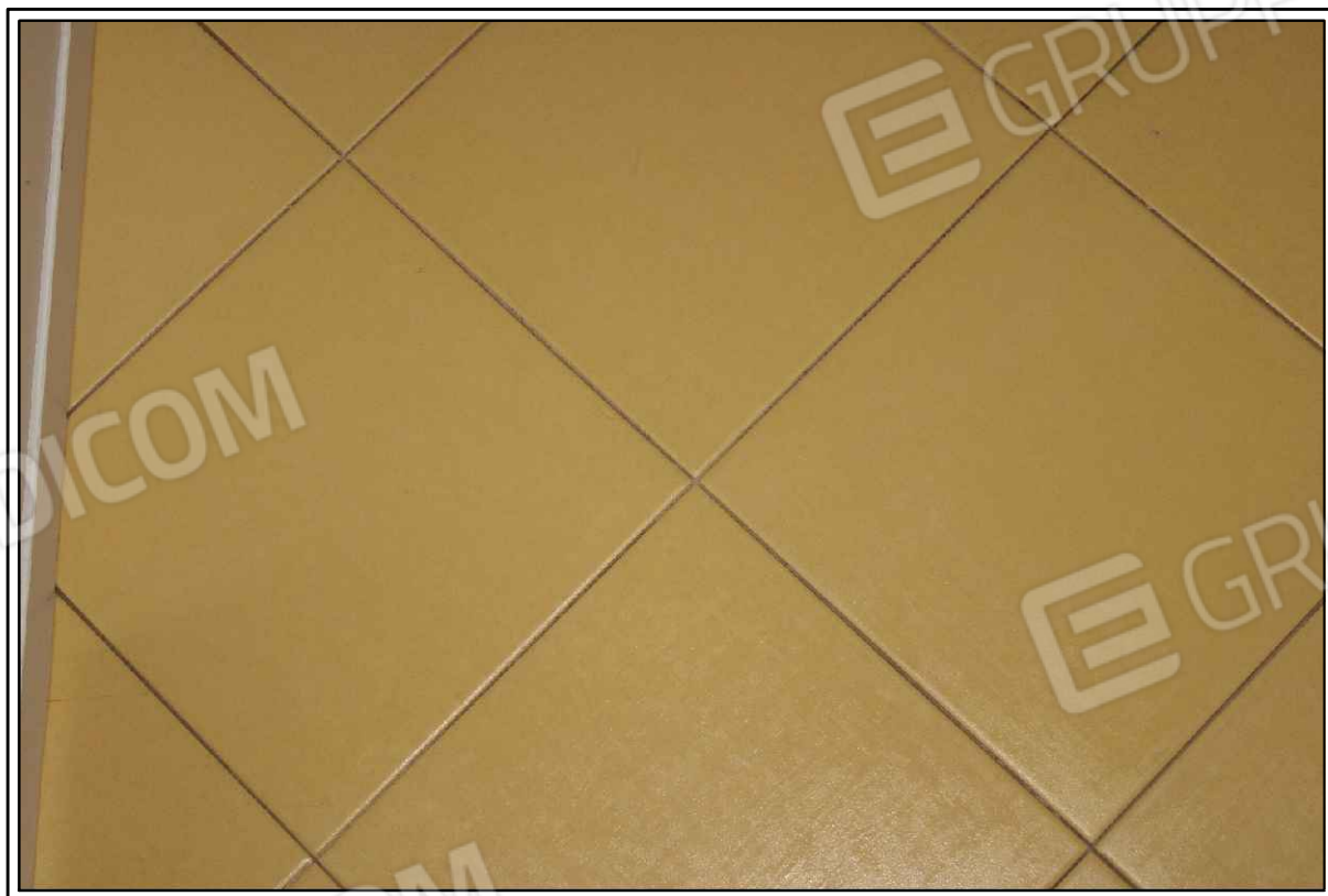
FOTO N° 46 - PARTICOLARE PAVIMENTO BAGNO
