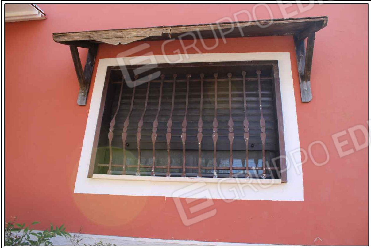
FOTO N° 53 - PARTICOLARE INFISSI ESTERNI
