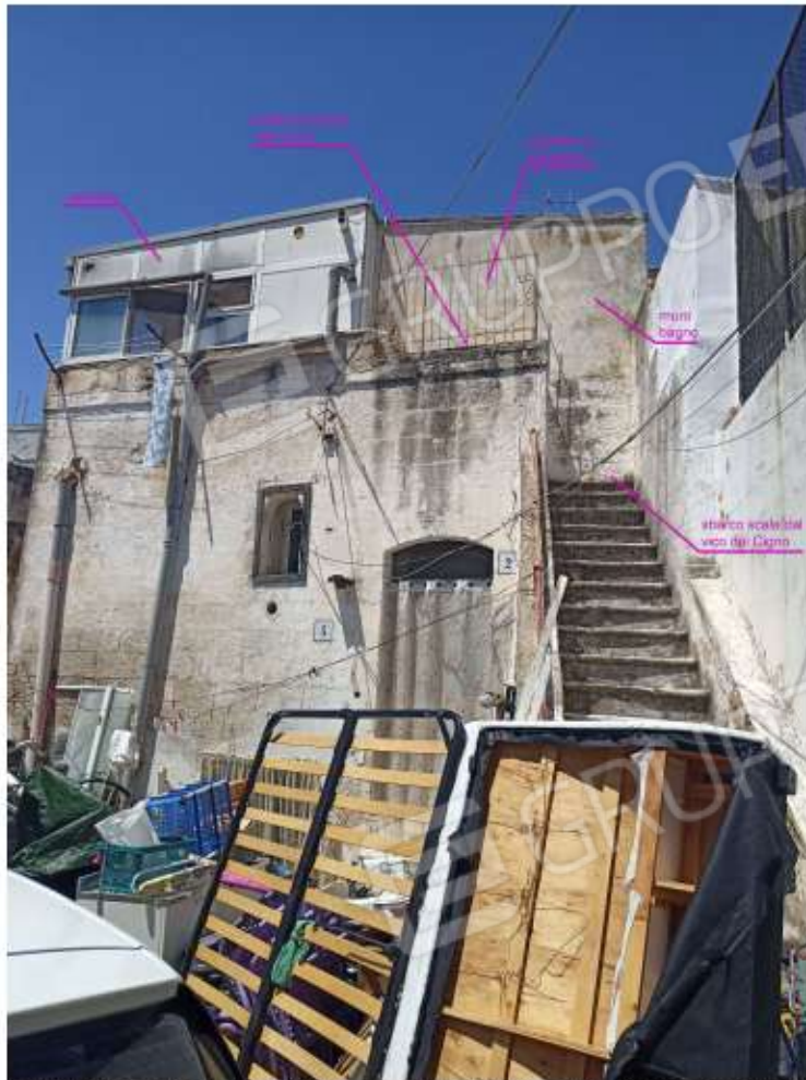
foto 13: prospetto retro edificio – scala dal vico del Cigno al terrazzino
