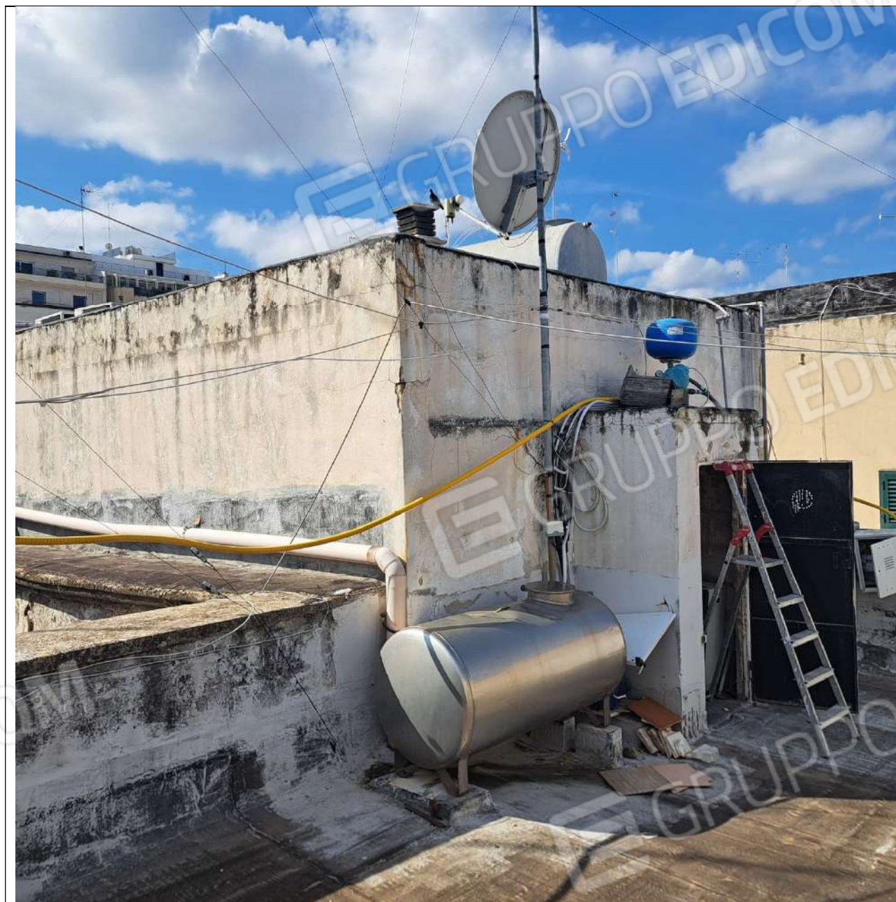
VISTA ESTERNA - 3 PIANO
