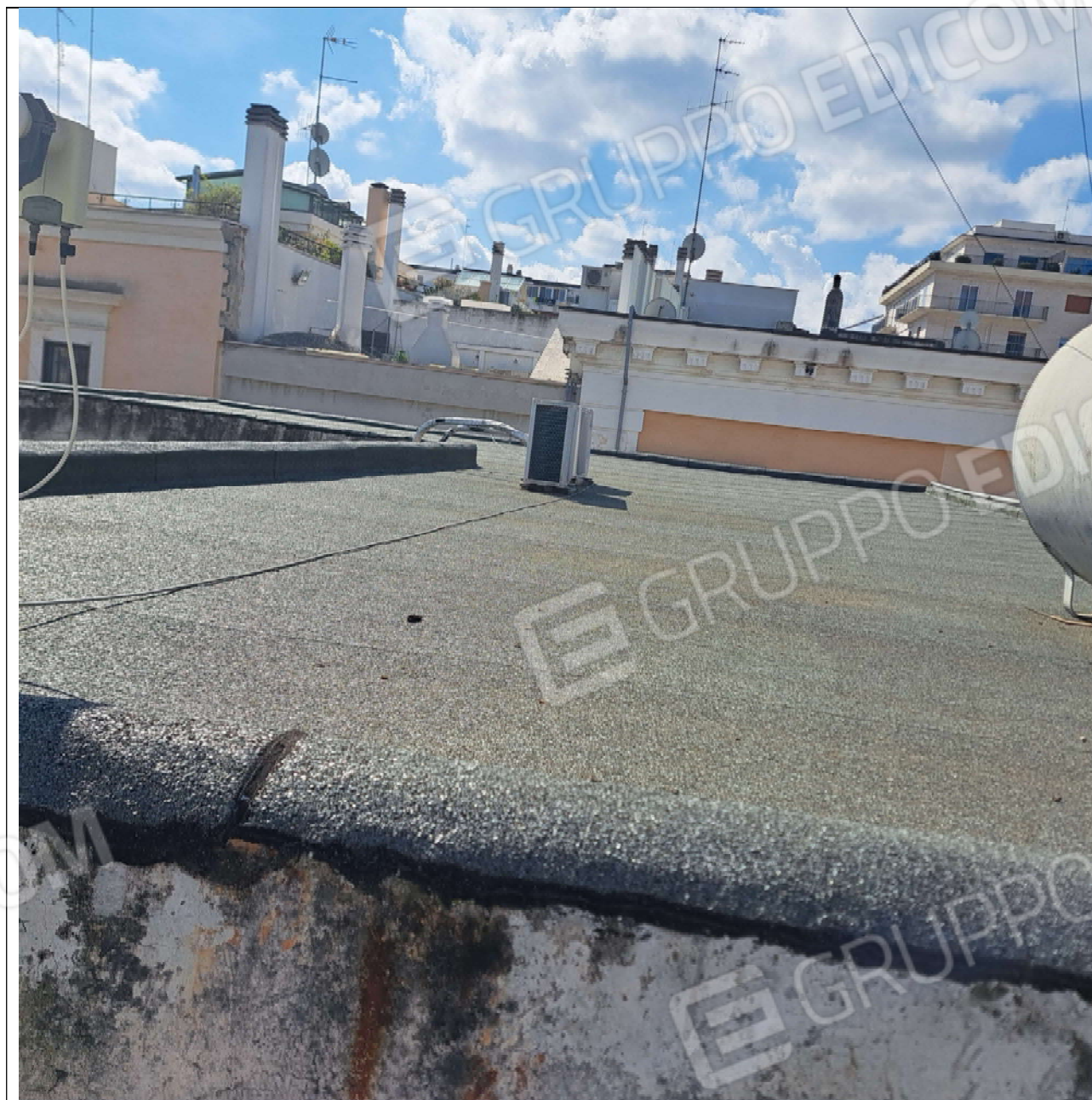
LASTRICO SOLARE COPERTURA - 3 PIANO
