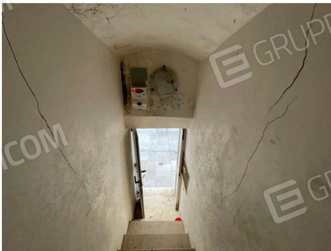
Scala di accesso
