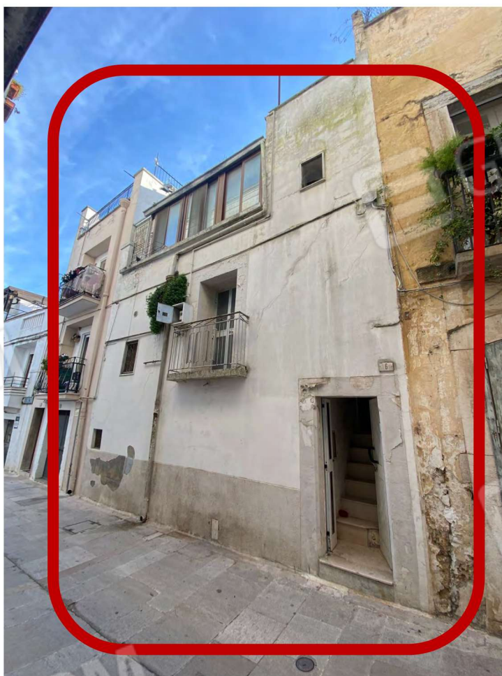
Vista complessiva dell'immobile , evidenziato in rosso
