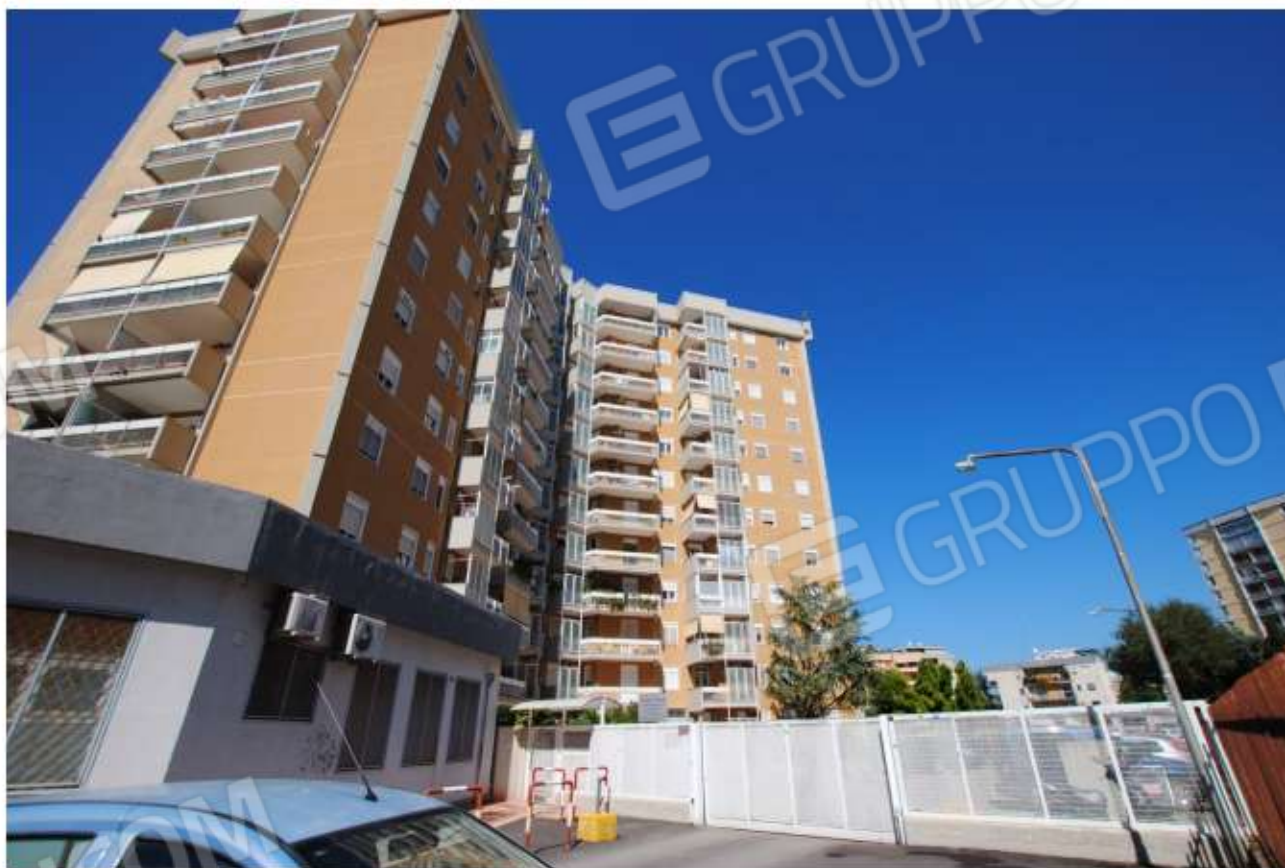
Foto 1: Ripresa dell'ingresso e del prospetto anteriore del fabbricato condominiale "Scala A-B-C) sito in Bari alla Via Giustino Fortunato n. 8/N.
