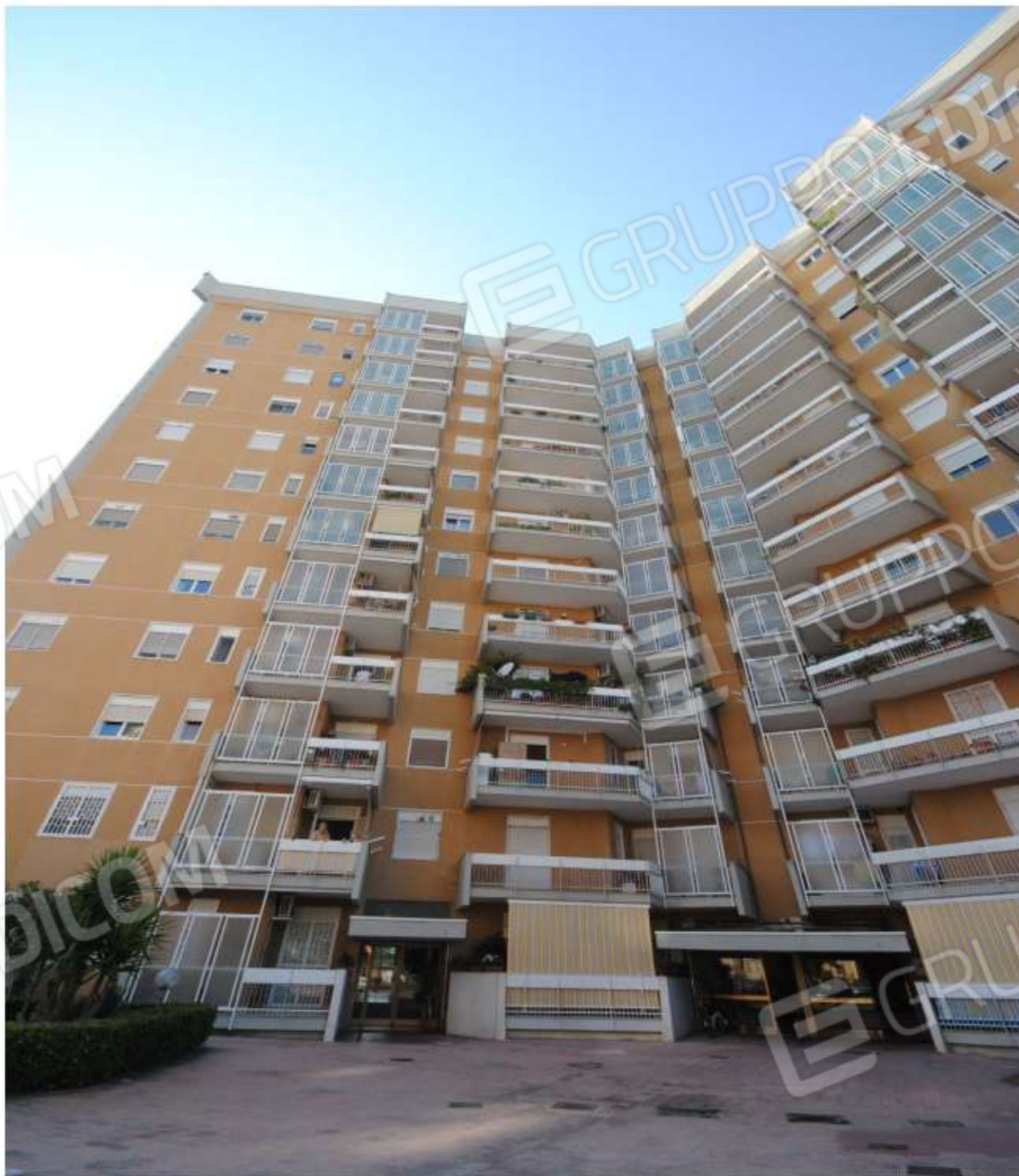
Foto 2: Ripresa del prospetto anteriore della scala A sull'atrio scoperto condominiale anteriore.
