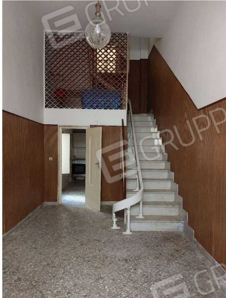
FOTO 2: PARTICOLARE DELL'ANDRONE E DEL VANO SCALE E DEL VANO RETROSTANTE
