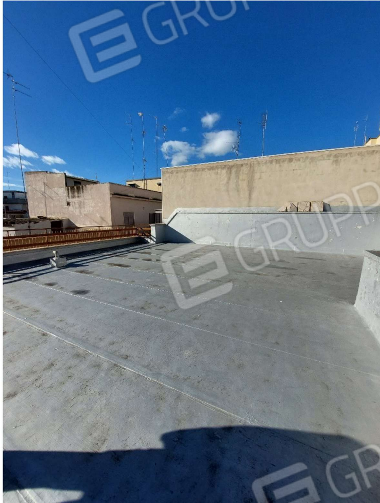
FOTO 5: VISTA DEL LASTRICO SOLARE
