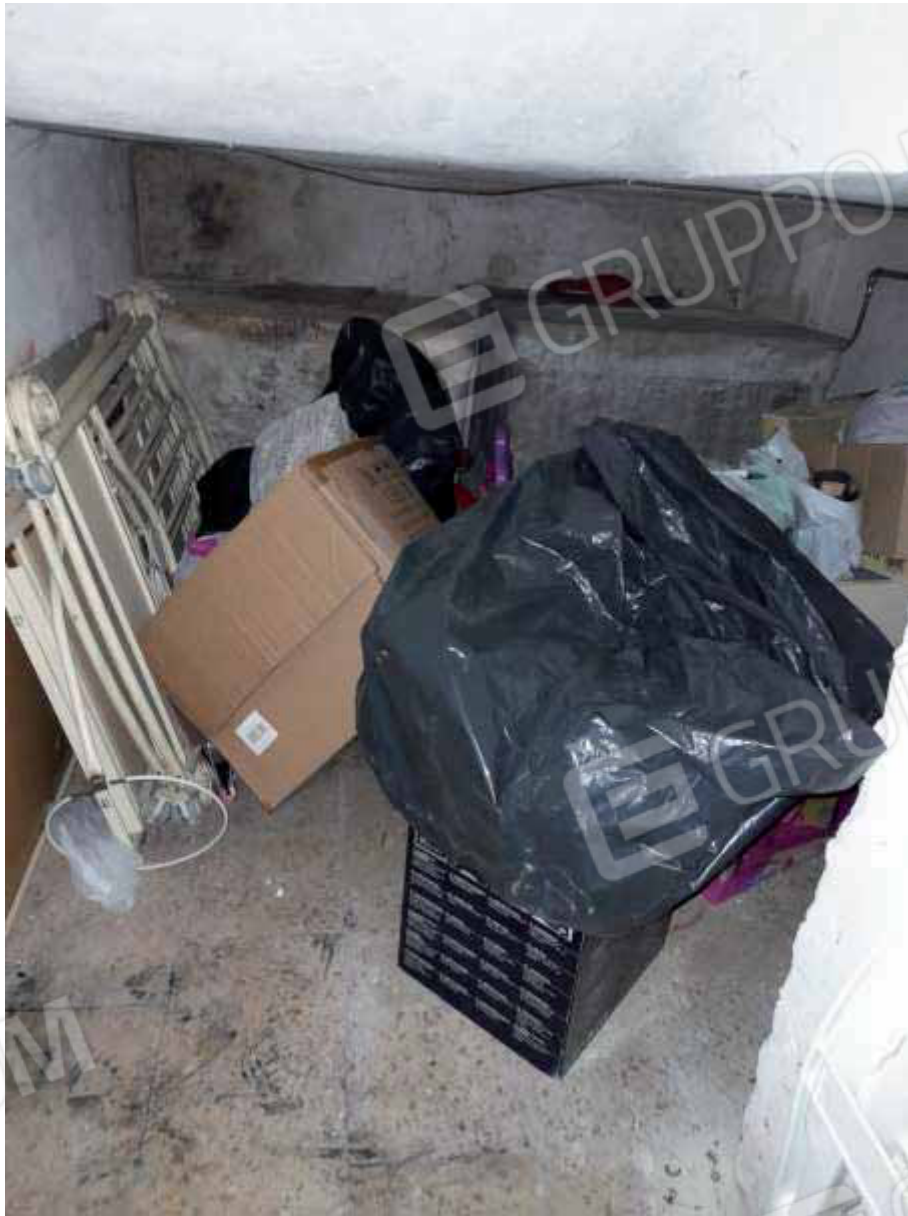
Foto 20) – Vista interno magazzino/sottoscala ( IMMOBILE B )
