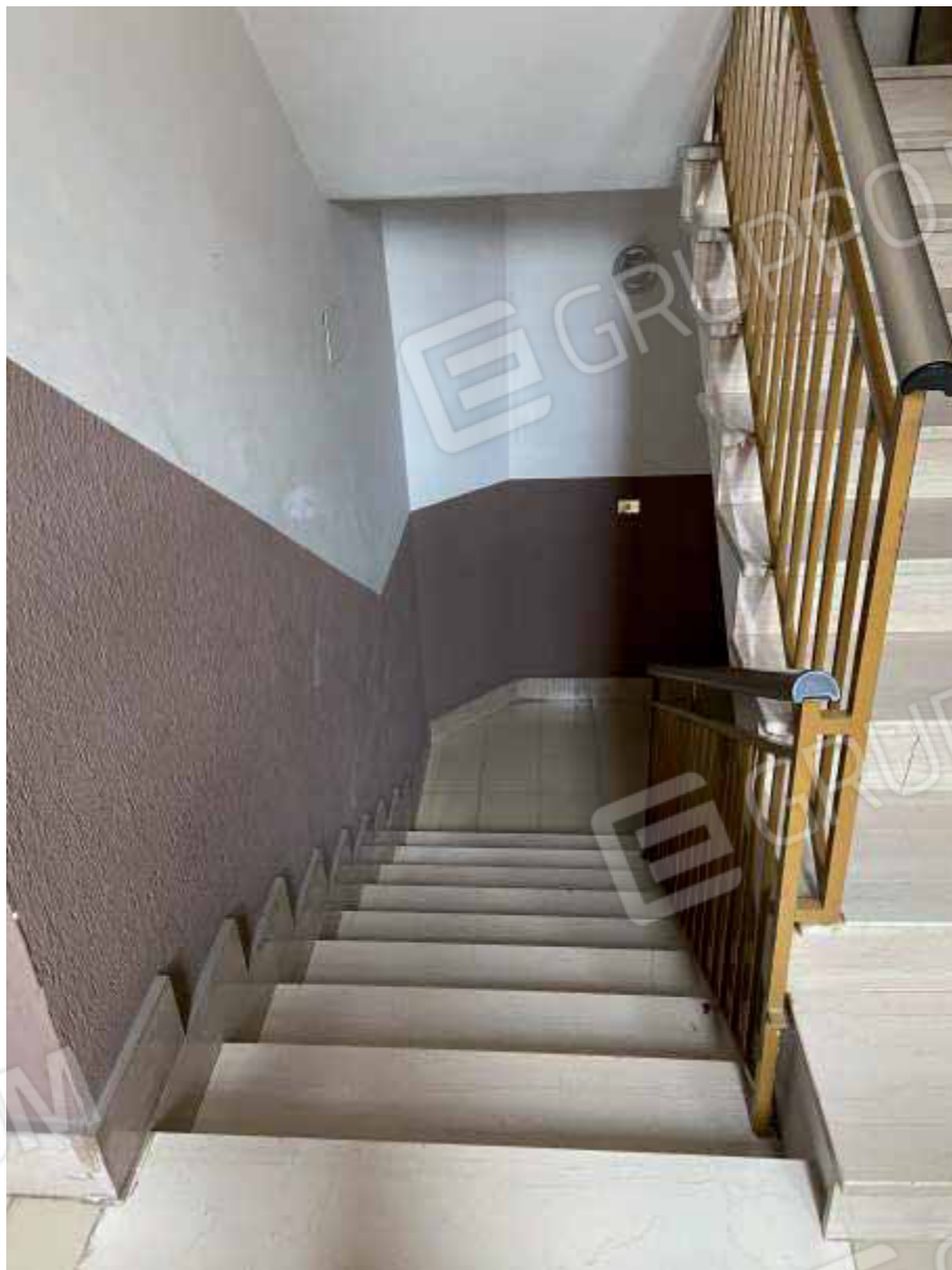
Foto 5) – Vista vano scala condominiale
