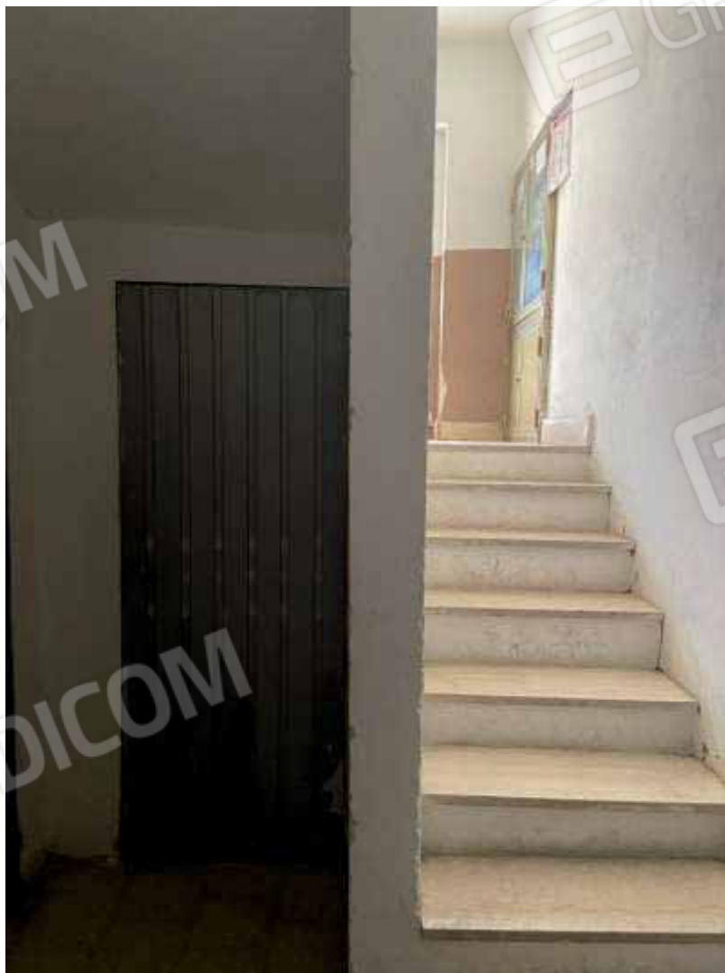
Foto 19) – Vista ingresso magazzino/sottoscala ( IMMOBILE B )
