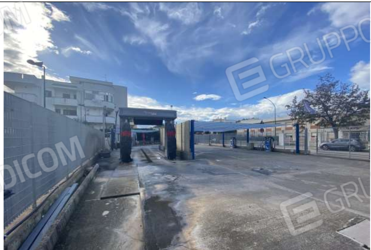
Foto 4) –IMMOBILE A: vista interna
