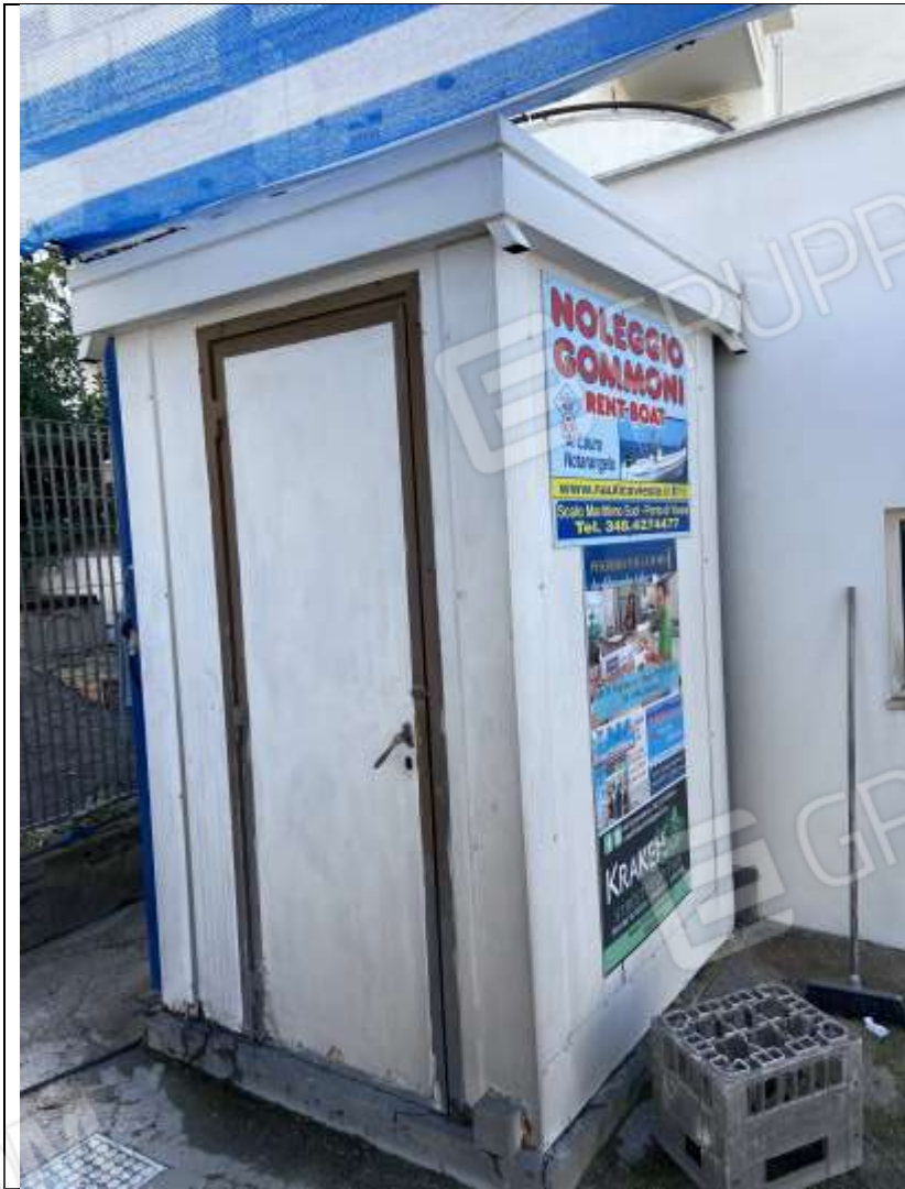
Foto 8) –IMMOBILE A: vista servizio igienico annesso a deposito
