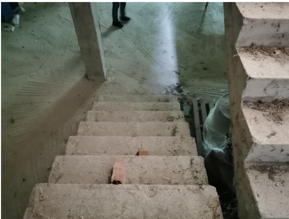
Figura 44: palazzina uffici esterna al capannone
