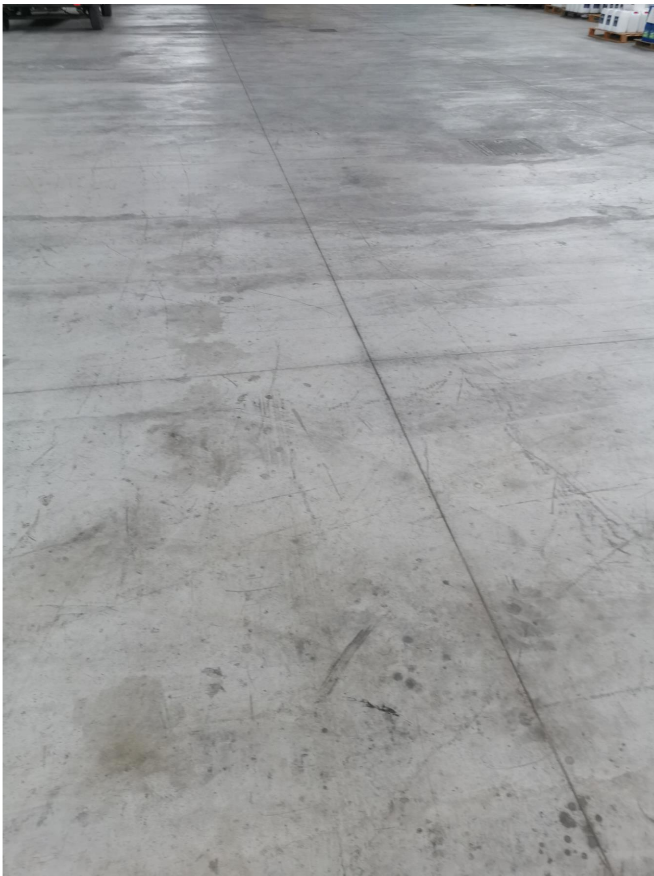
Figura 24: interno capannone industriale (pavimentazione)
