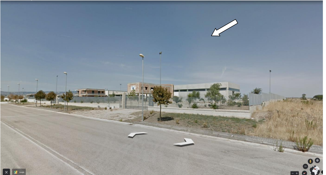
Figura 5: ingresso carrabile capannone industriale
