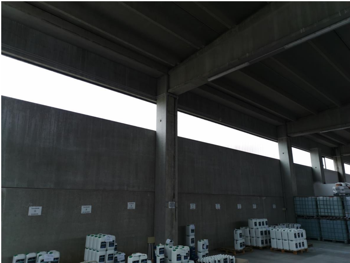
Figura 20: interno capannone industriale
