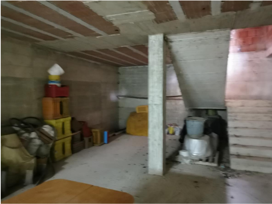
Figura 46: palazzina uffici esterna al capannone
