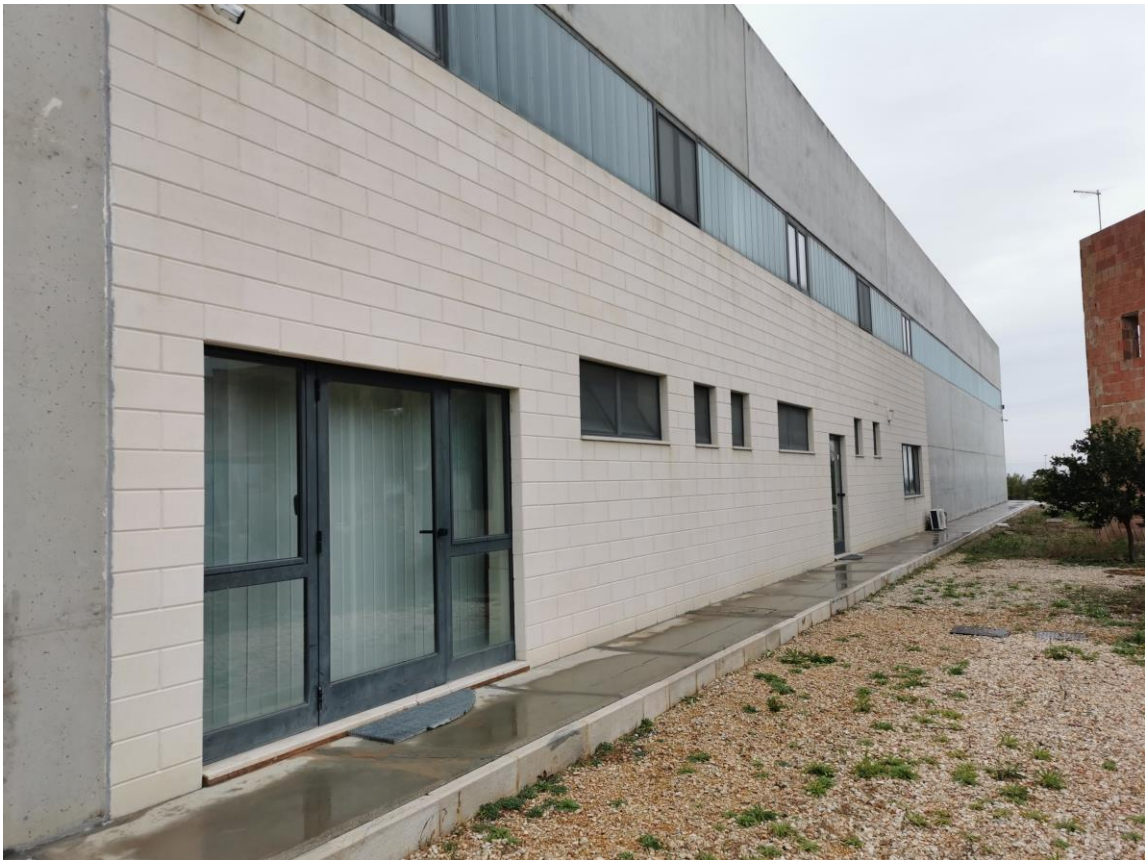
Figura 17: esterno capannone industriale zona ingresso uffici interni al capannone
