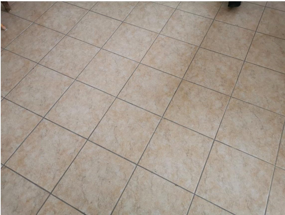
Figura 32: interno capannone industriale (zona uffici interni al capannone)
