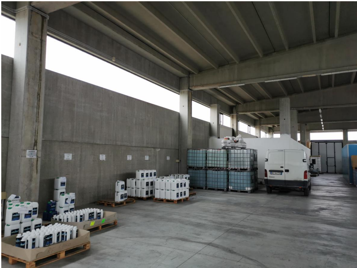
Figura 22: interno capannone industriale
