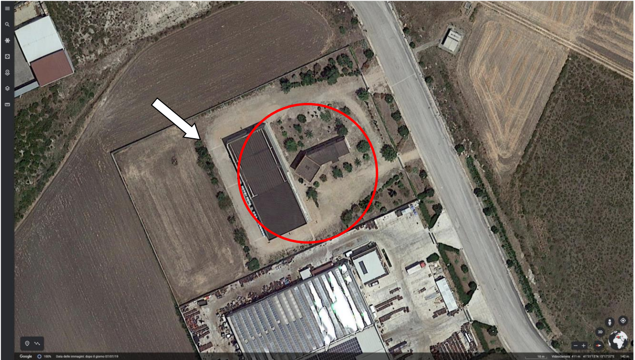
Figura 3: capannone industriale - Strada Statale 89, Km 170, 500, 71043 Manfredonia FG (41.595967, 15.869474)
