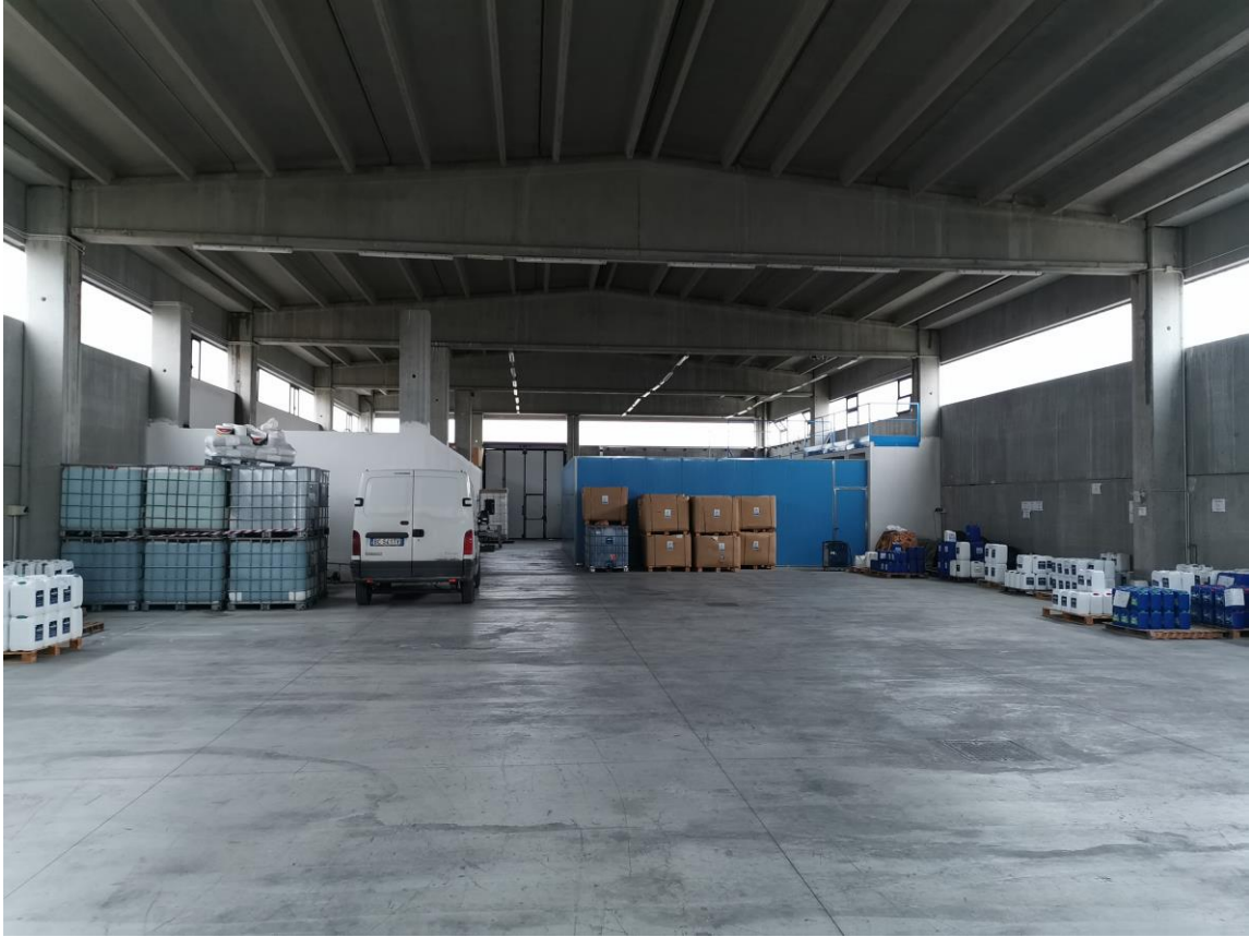
Figura 18: interno capannone industriale
