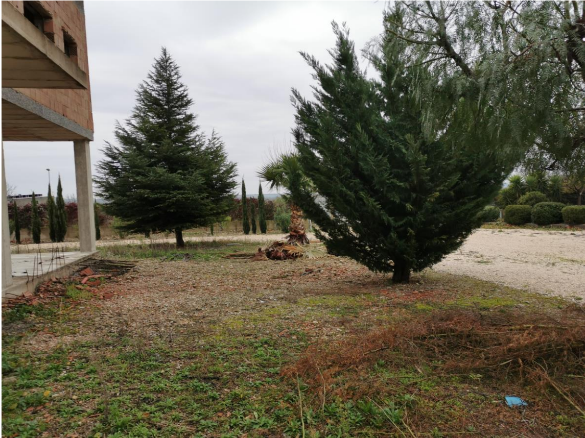
Figura 39: palazzina uffici esterna al capannone
