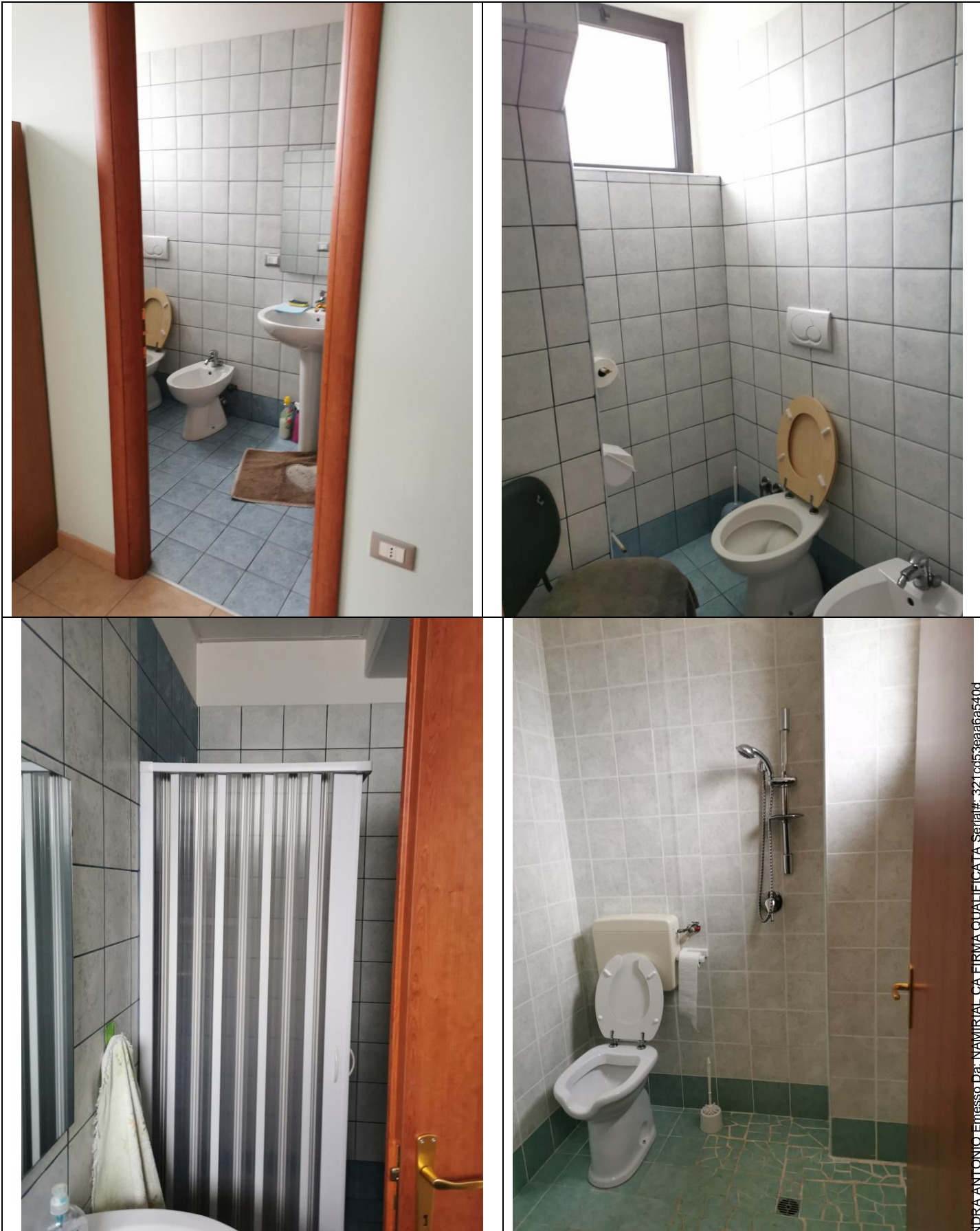
Figura 37: WC nella zona uffici interni al capannone
