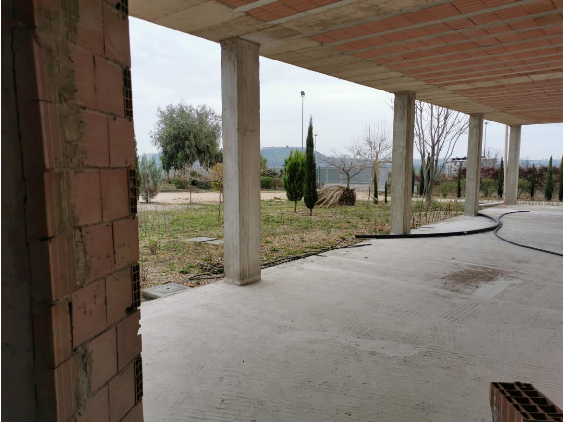
Figura 43: palazzina uffici esterna al capannone
