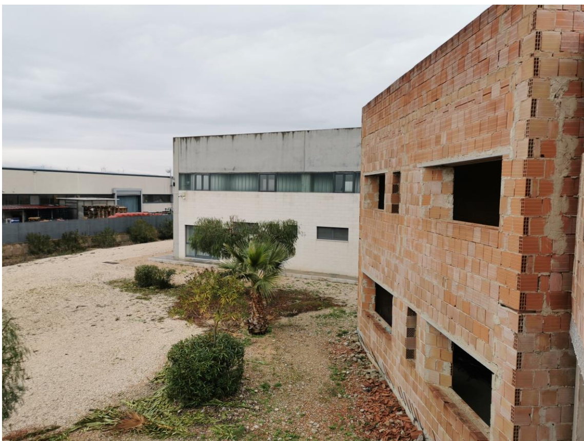
Figura 50: palazzina uffici esterna al capannone
