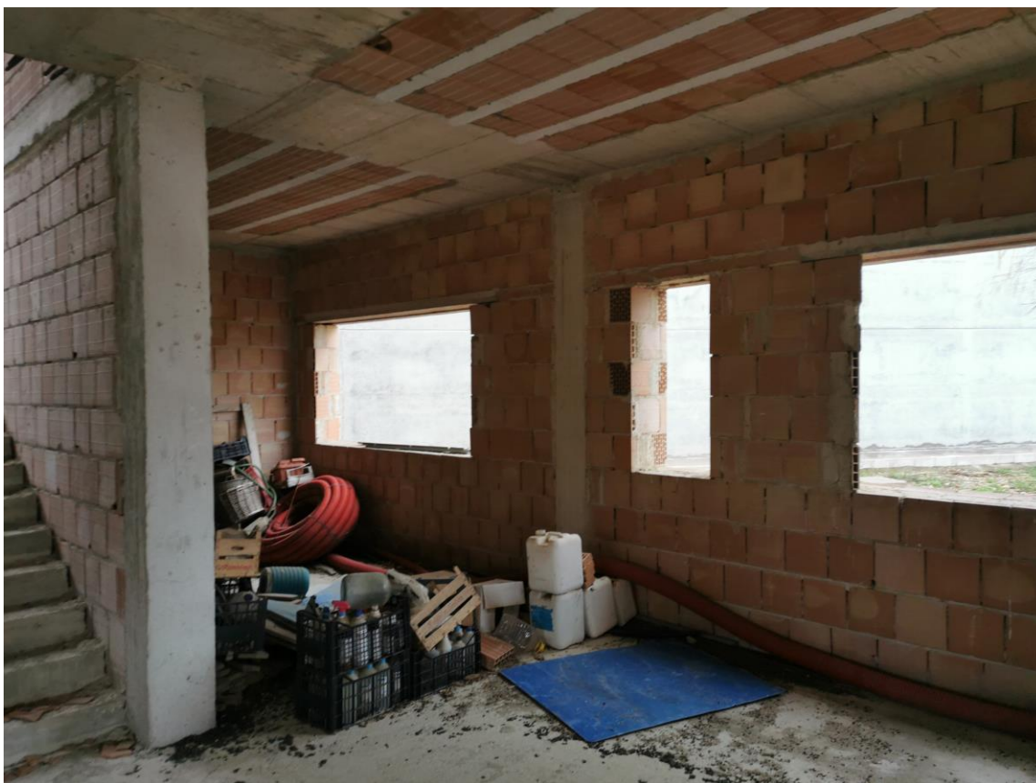
Figura 51: palazzina uffici esterna al capannone
