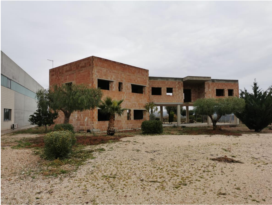
Figura 38: palazzina uffici esterna al capannone
