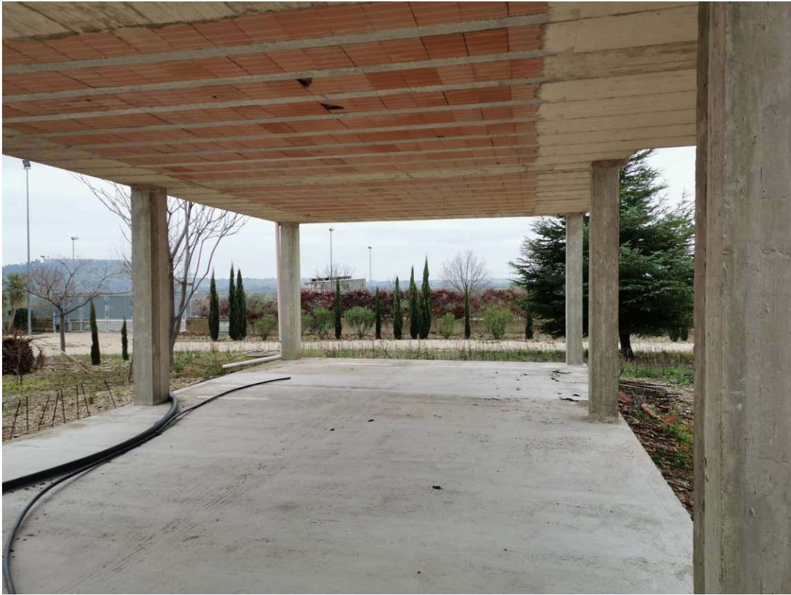
Figura 42: palazzina uffici esterna al capannone
