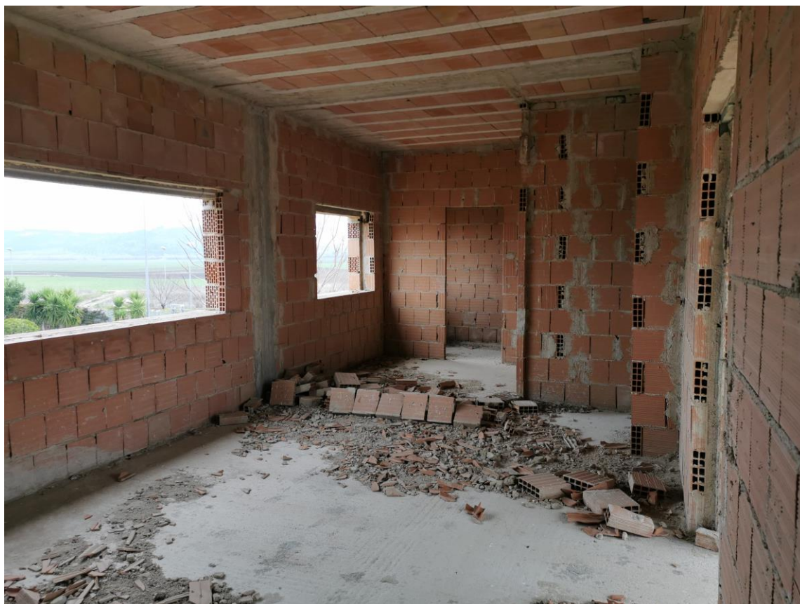
Figura 49: palazzina uffici esterna al capannone
