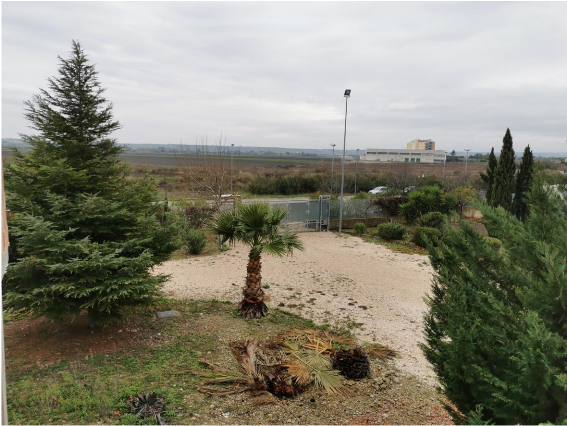
Figura 40: palazzina uffici esterna al capannone
