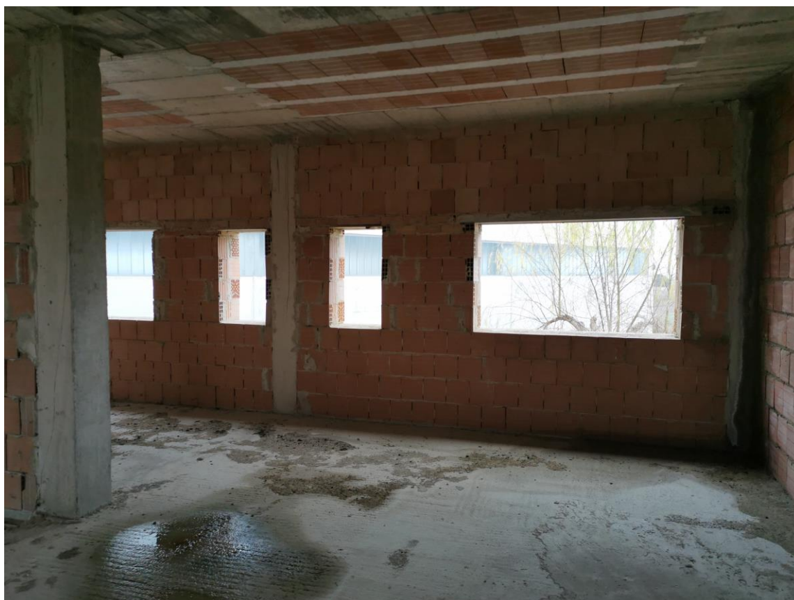
Figura 48: palazzina uffici esterna al capannone
