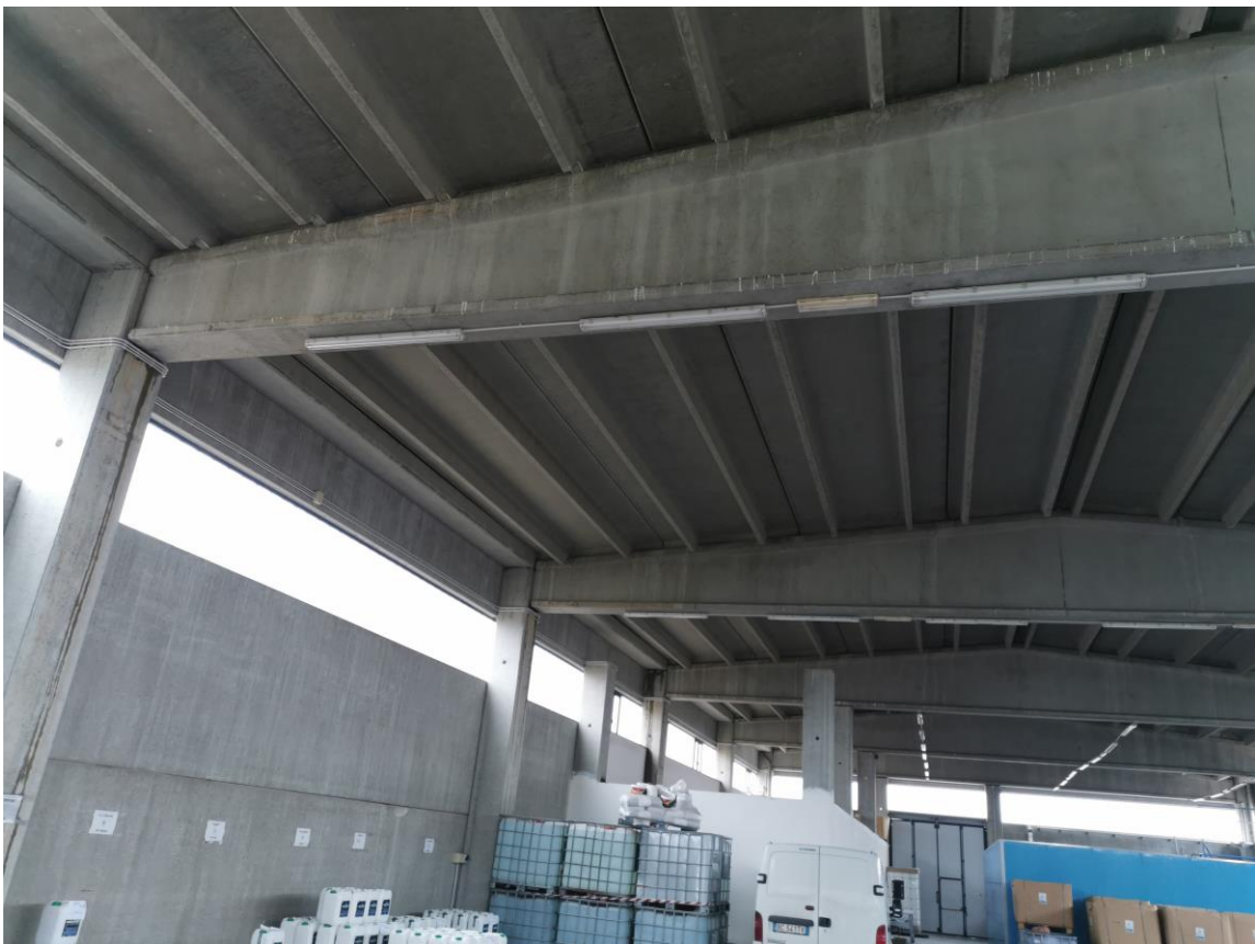
Figura 19: interno capannone industriale
