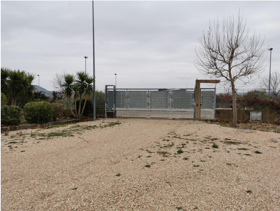
Figura 7: ingresso carrabile capannone industriale
