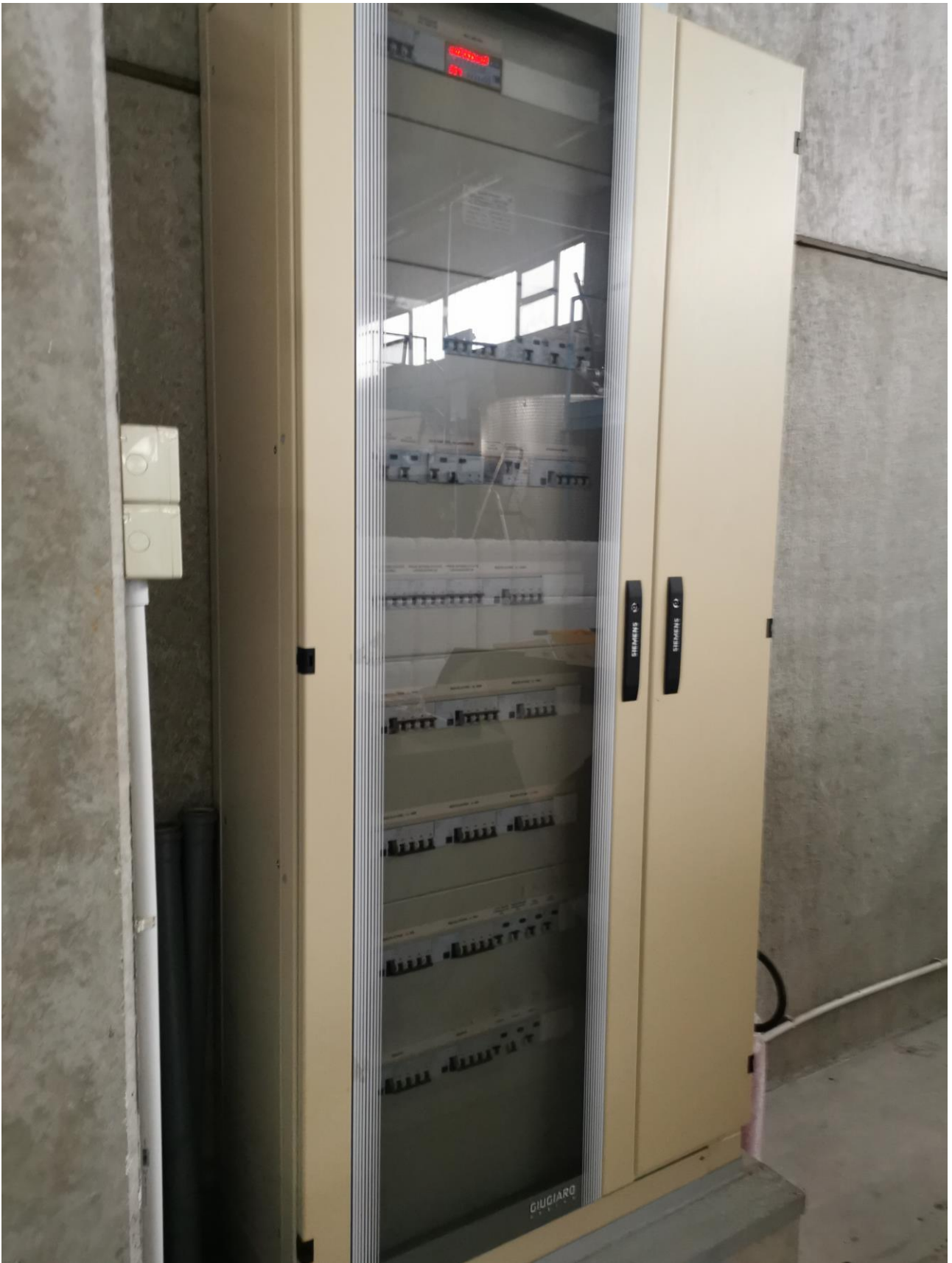
Figura 26: interno capannone industriale
