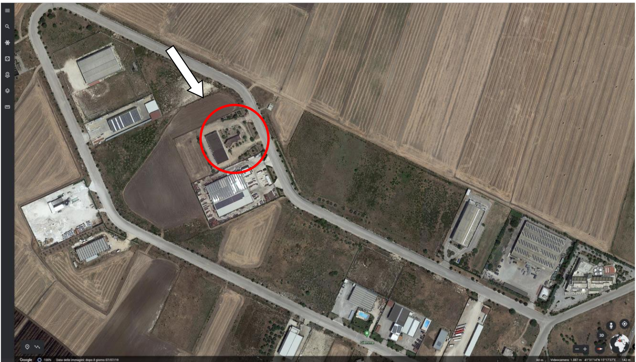
Figura 2: capannone industriale - Zona Industriale di Lucera (FG) – ZONA ASI (41.520948, 15.293695)
