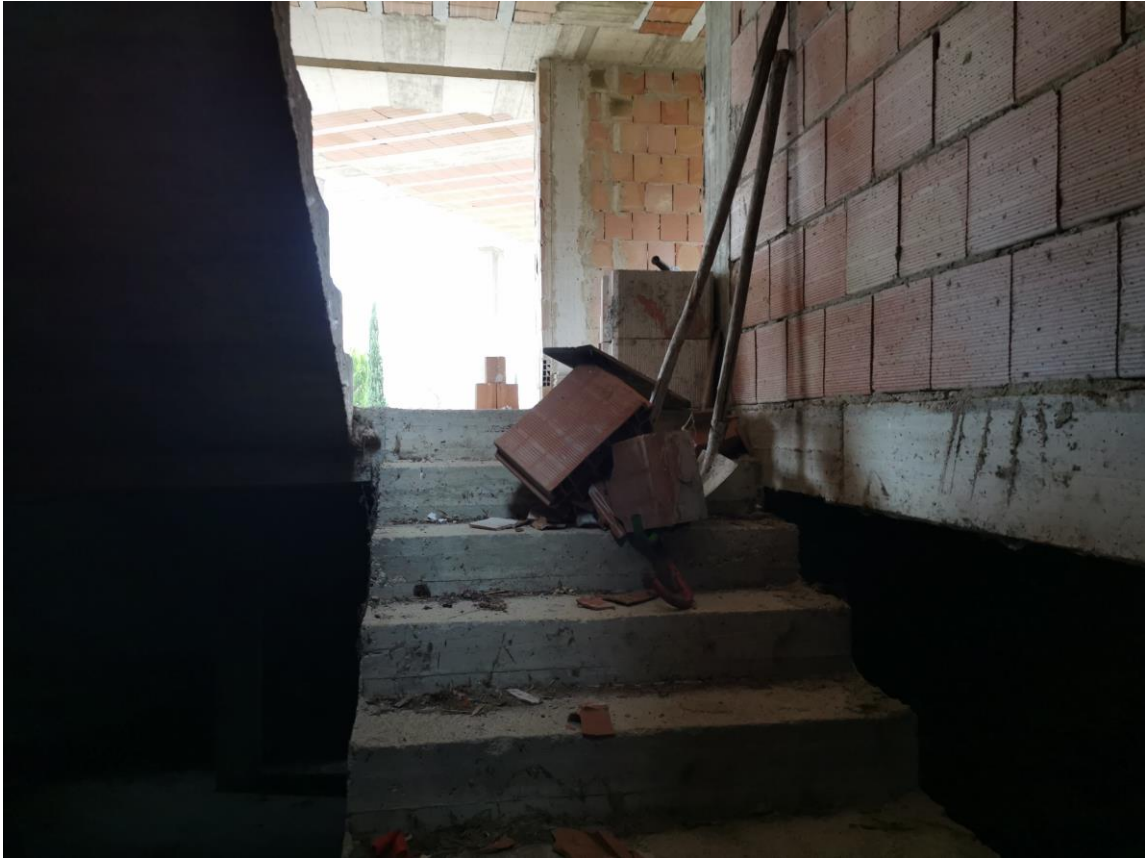
Figura 47: palazzina uffici esterna al capannone
