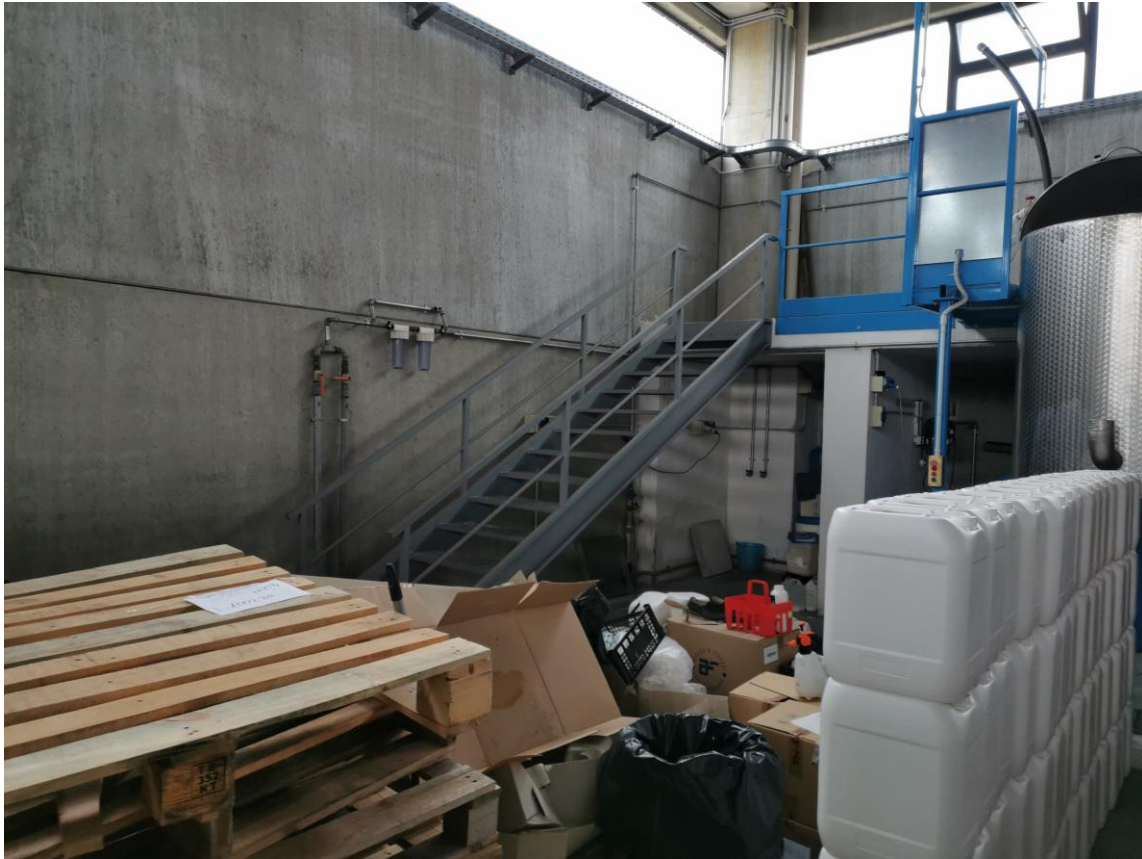
Figura 27: interno capannone industriale (zona di accesso al soppalco)
